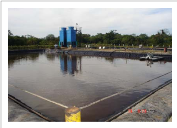
FOTO 18. TORRES DE ENFRIAMIENTO PISCINA 3.
