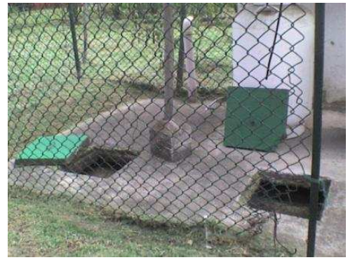
Foto 11. Pozos de inspección del tanque
