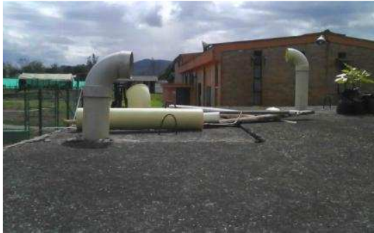
Foto 7. Chimeneas para dispersión de gases
