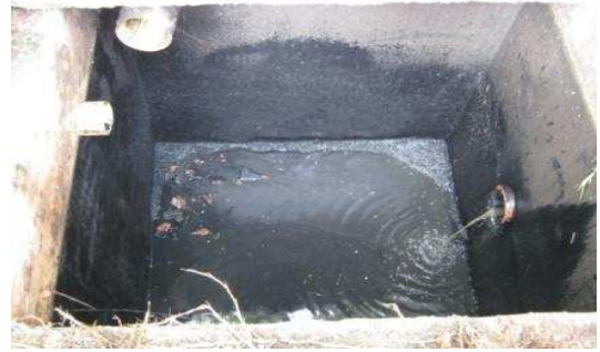
Foto 2. Tanque desarenador
