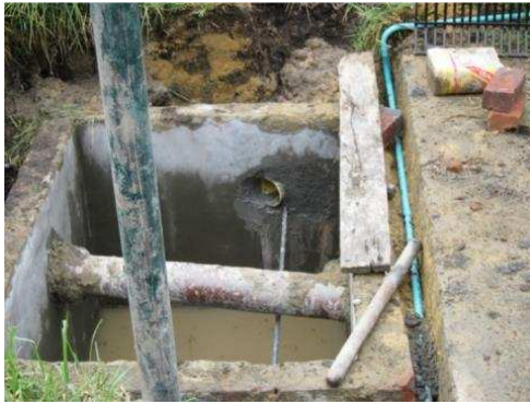
Foto 10. Construcción Trampa de solidos (rejilla)
