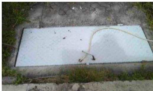
Foto 12. Dosificación solución acidulante en rejilla
