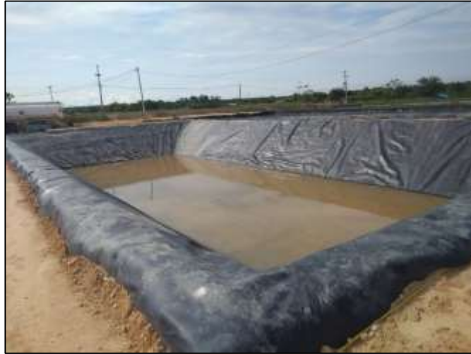
Figura 10. Piscinas de almacenamiento de residuos de la empresa SOLUXIONAR ubicada en Sabana de Torres, Santander.
