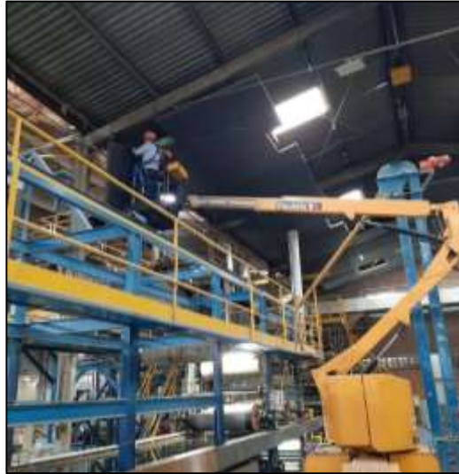
Figura 14. Proceso de instalación de láminas en la empresa FIBERGLASS ubicada en Girón, Santander.
