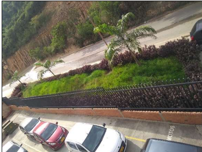
Figura 15. Lugar de adaptación y construcción de parqueadero en la empresa DISPAPELES ubicada en Girón, Santander
