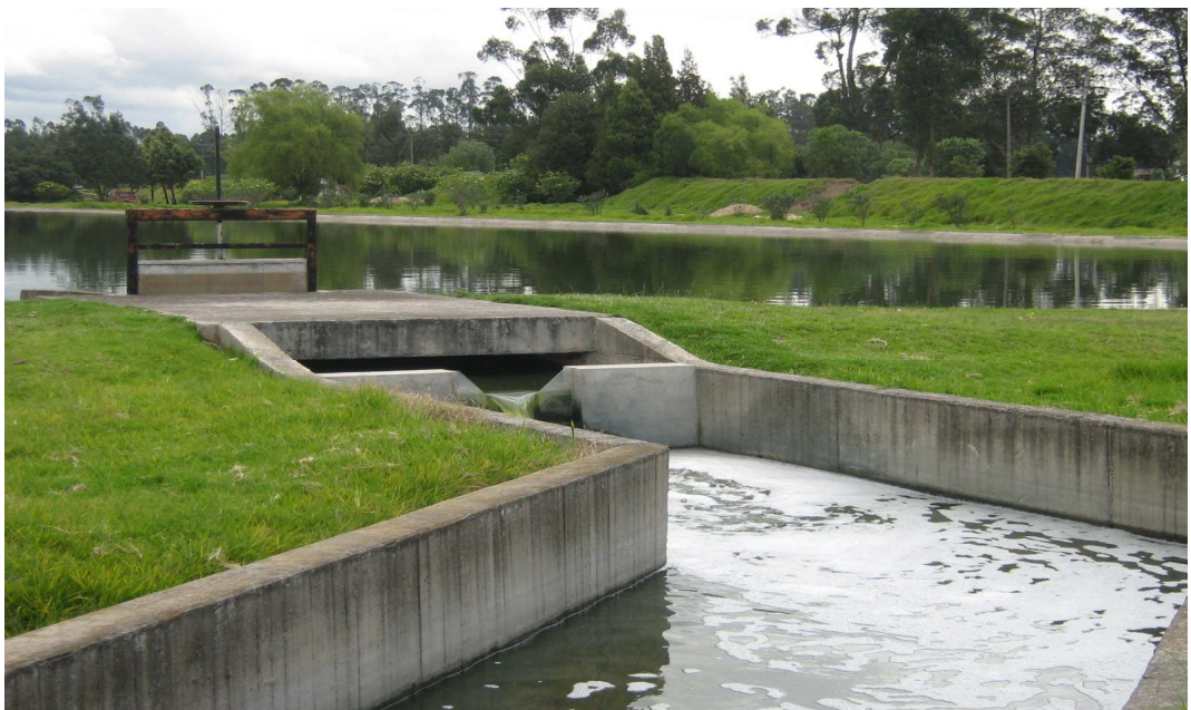
Foto 8. Estructura de Aforo y Descarga del Efluente
