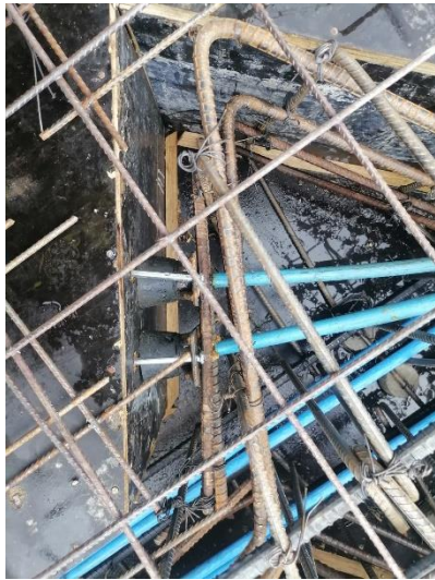
Figura 8. Anclajes montados. Fuente: Propia
