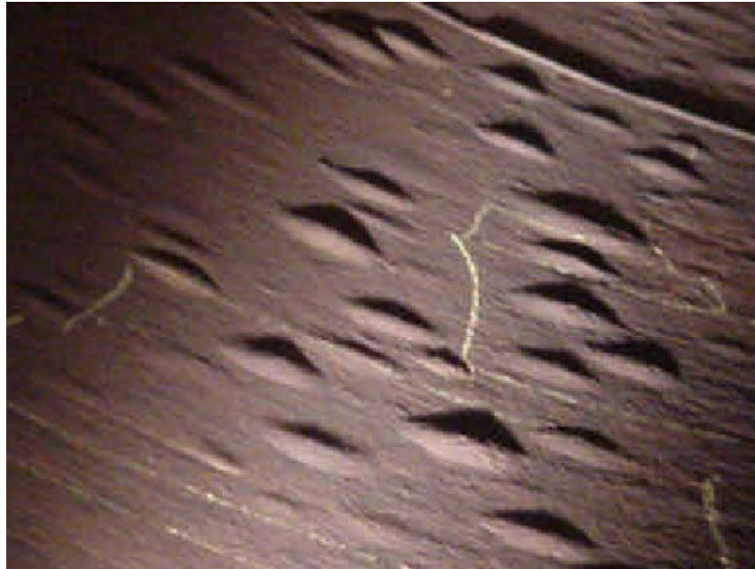
Foto 1. Ampollamiento por hidrógeno en casco de tambor de una unidad despojadora de aguas agrias
