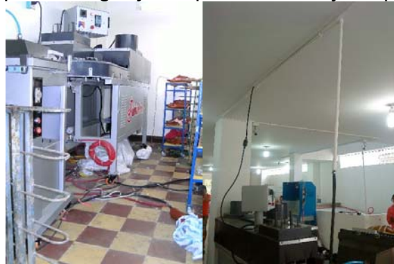
Figura 8. Cableado para energía y compresor: antes y después
