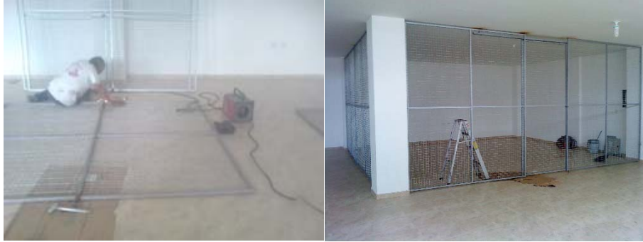
Figura 3. Adecuación de bodega de materiales
