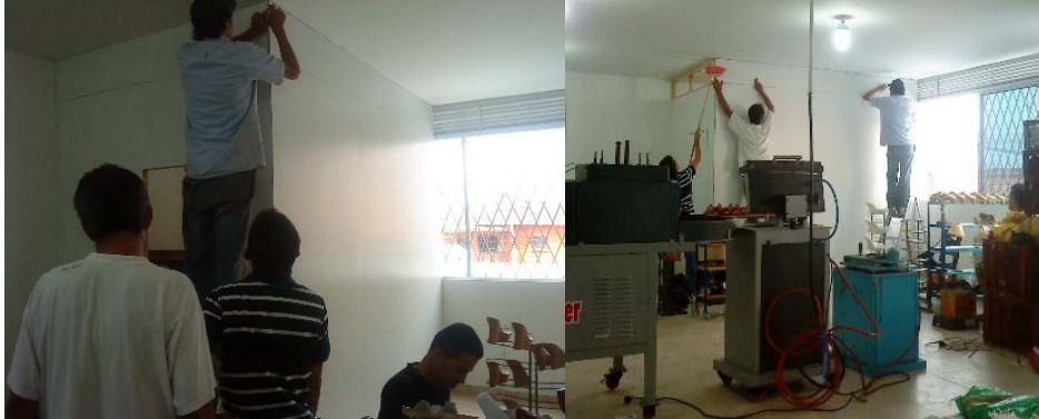
Figura 5. Adecuación para cuarto de puesto de acabado
