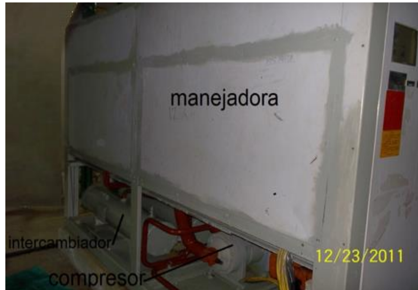
Figura 14. Equipo paquete condensado por agua
