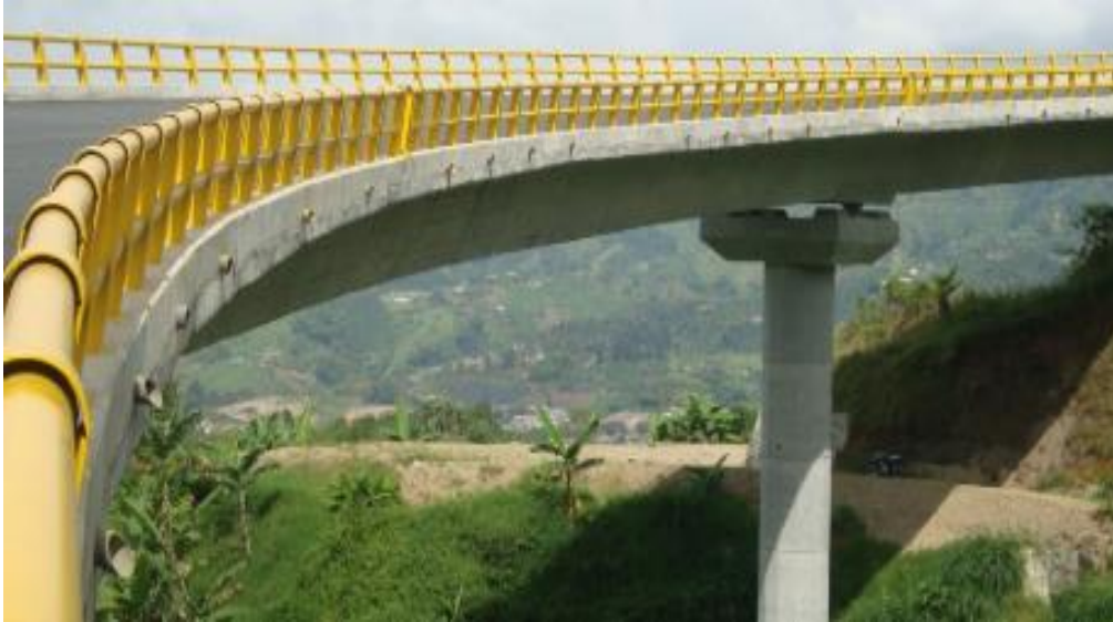
Figura 19. Viaducto helicoidal, santa rosa de cabal-Primer puente aislado
