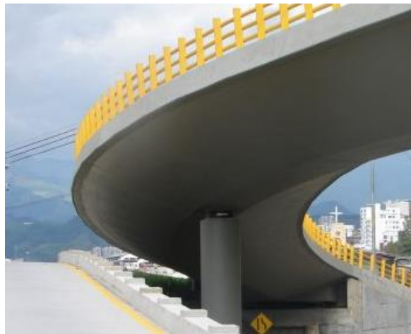
Figura 22. Puente calle 33, Manizales, 2016
