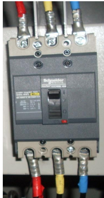
Ilustración 38 Interruptor termomagnético EZC100N-60 A
