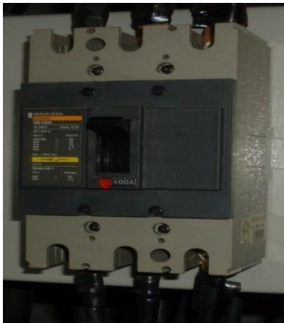
Ilustración 25 Interruptor termomagnético EZC100N-100 A
