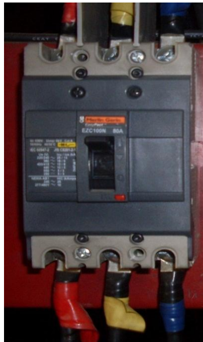
Ilustración 15 Interruptor termomagnético EZC100N-80 A
