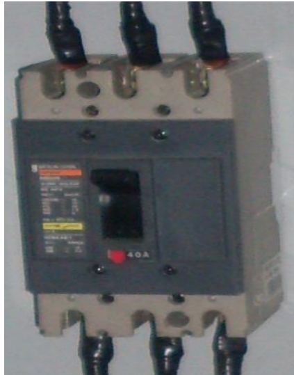
Ilustración 28 Interruptor termomagnético EZC100N-40 A
