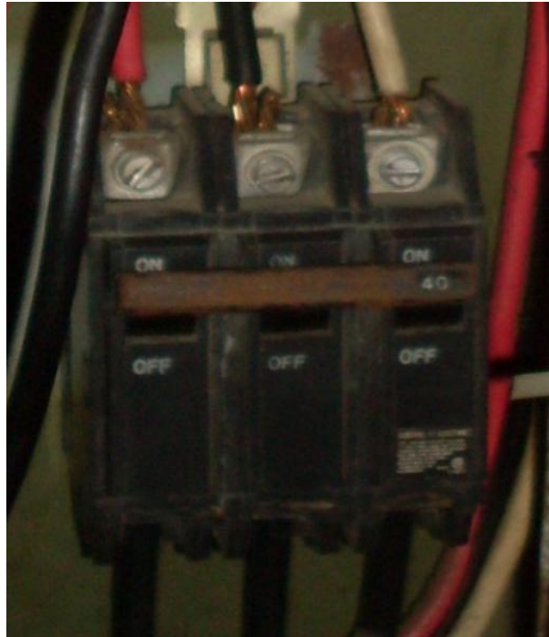
Ilustración 18 Interruptor termomagnético THQC-40 A
