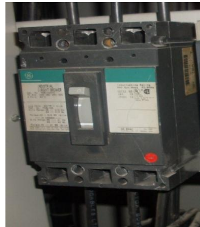
Ilustración 26 Interruptor termomagnético TEB132070
