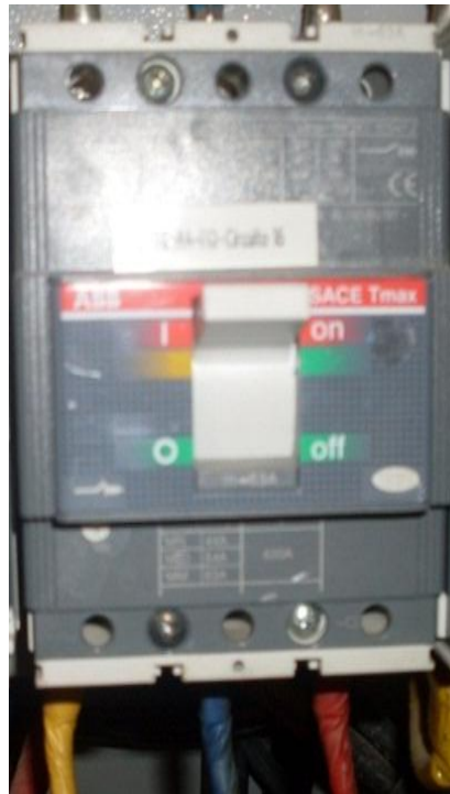
Ilustración 21 Interruptor termomagnético TMAX-T1
