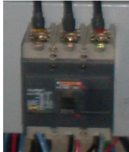
Ilustración 29 Interruptor termomagnético EZC100N-30 A
