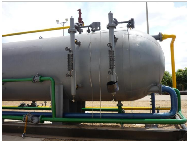
Figura 15. Equipo FWKO. Líneas de Gas (Amarillas), Línea de Agua (Azul) y Línea de Crudo (Verde)
