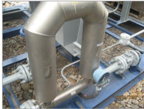
Figura 19. Medidor de flujo Másico Coriolis
