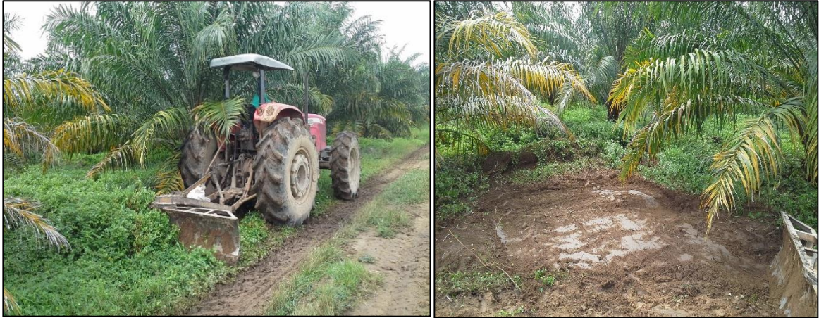
Figura 36. Adecuación de puntos de acopio
