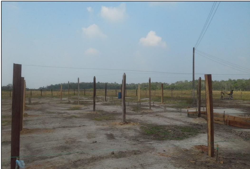
Figura 14. Disposición de columnas de madera, base del área de poli-sombra
