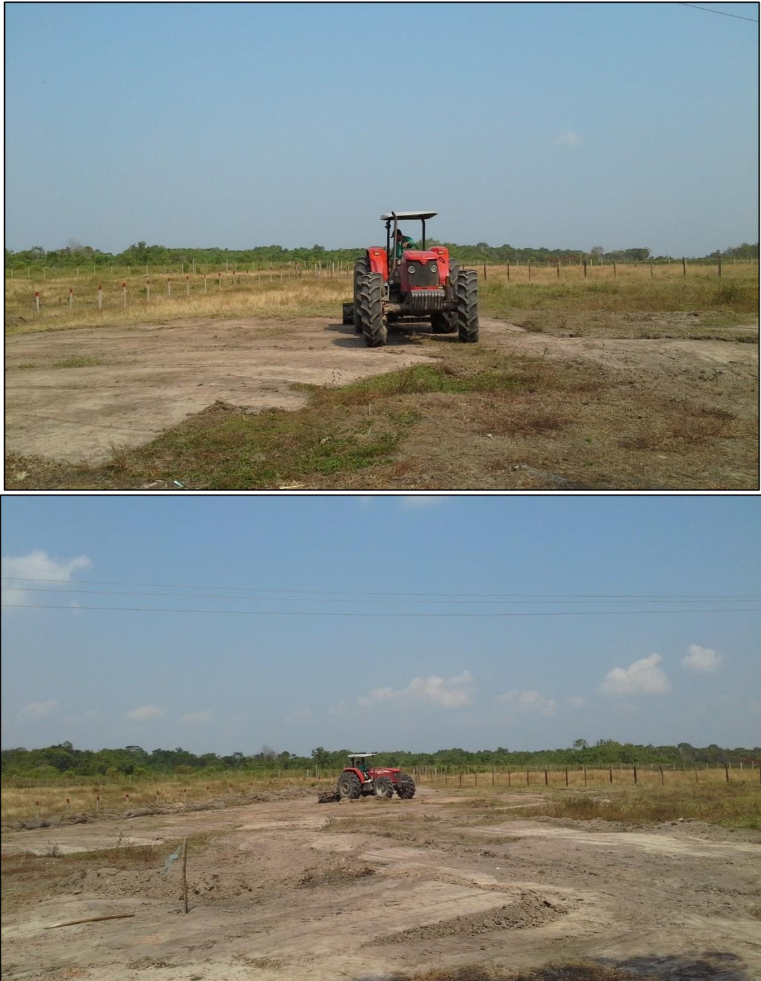
Figura 13. Proceso de preparación del terreno
