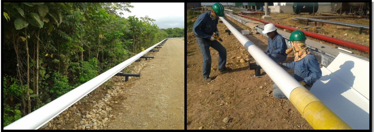
Figura 41. Tubería Aislada con PRFV
