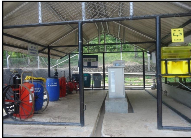
Figura 13 Caseta de Implementos de Seguridad
