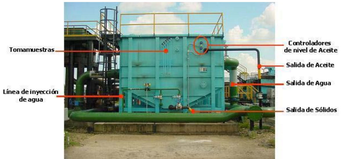
Figura 16. Unidades CIP del campo, 80.000 BPD/CU
