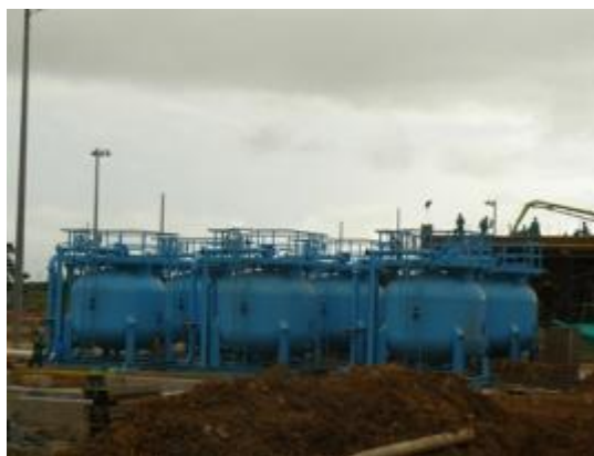
Figura 18. Filtros del campo, 50.000 BPD/CU
