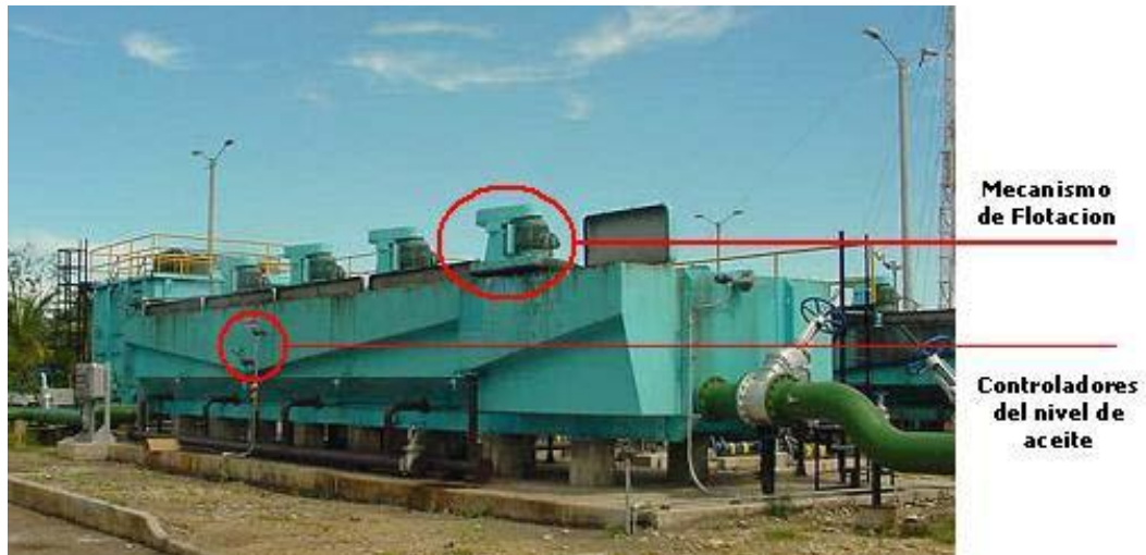
Figura 17. Celdas de flotación campo, 120.000 BPD/CU
