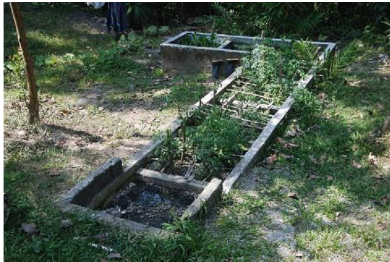
Figura 10. Planta piloto para depurar agua residual de una familia de 7 personas en zona rural de Santa Marta, Colombia
