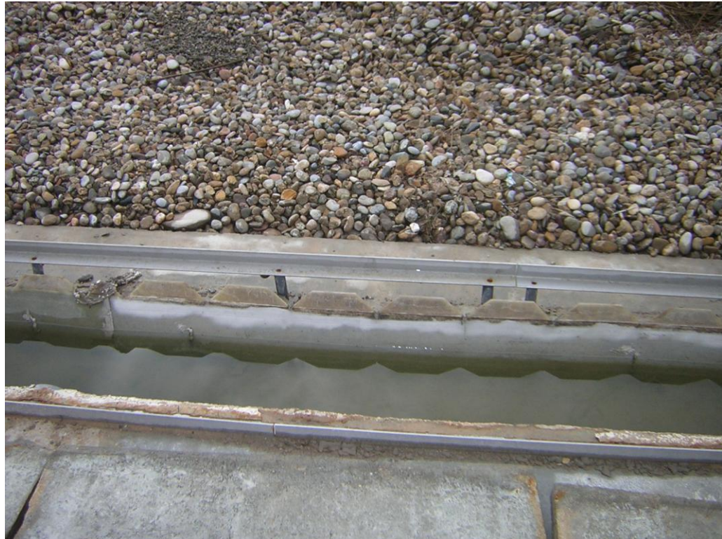
Figura 8. Cámara de infiltración en la entrada de un HCFSSH en Alfes, Cataluña.
