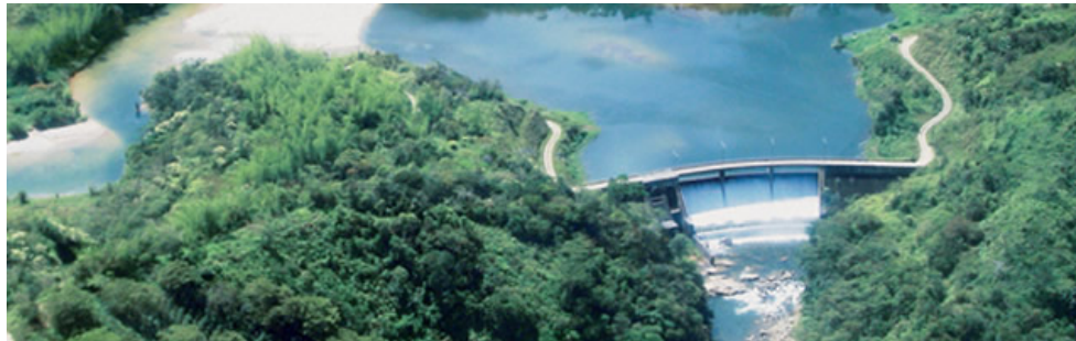
Figura 5: Central Hidroeléctrica Calderas
