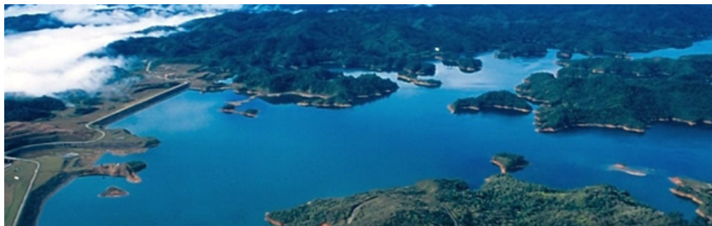
Figura 4: Central Hidroeléctrica Jaguas
