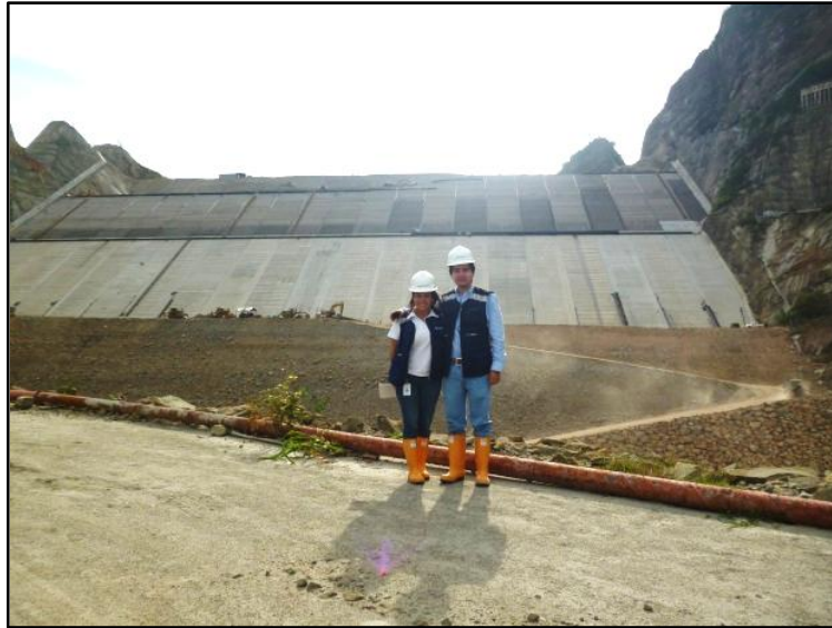
Figura 37: Visita a obra – Construcción Presa.
