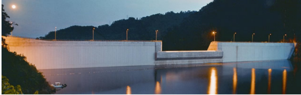
Figura 3: Central Hidroeléctrica Miel I
