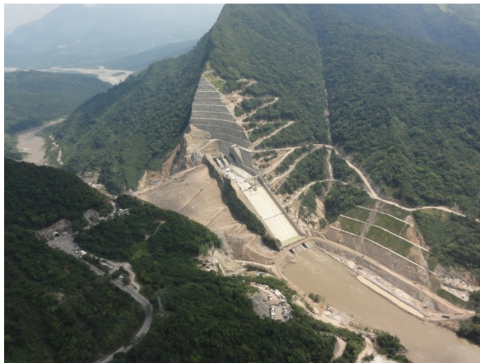
Figura 8: Proyecto Hidroeléctrico Sogamoso
