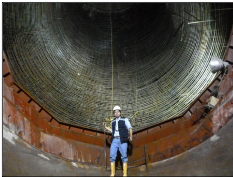
Figura 34: Visita a obra – Construcción Codos inferiores de carga.
