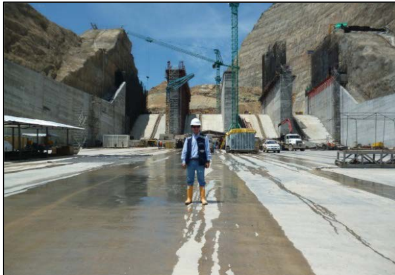
Figura 36: Visita a obra – Vertedero, Construcción Estructura de control.
