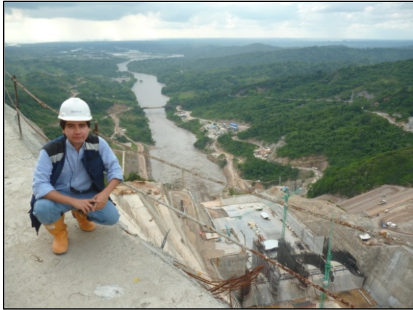
Figura 35: Visita a obra – Panorámica Vertedero.
