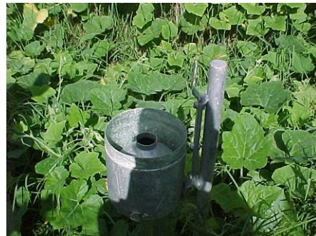
Fig. 22 Detalle Pluviómetro (CDMB)
