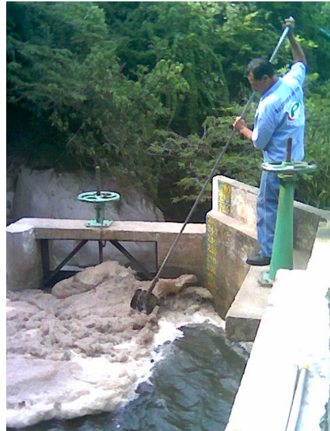
Fig. 18 Taponamiento de la compuerta
