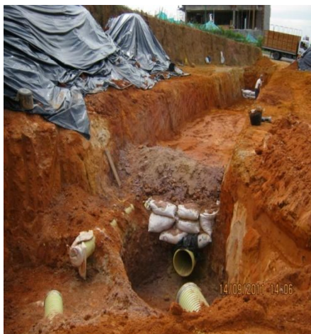
Figura 13. Red alcantarillado pluvial
