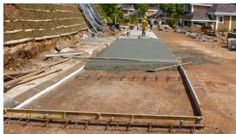
Figura 6. Fundida de pavimento rígido
