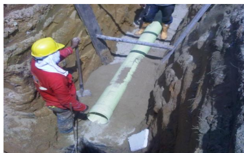
Figura 3. Instalación tubería aguas negras
