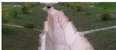
Figura 11. Canal trapezoidal en concreto
