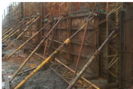
Figura 14. Construcción muro contención
