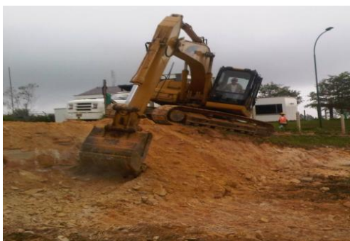
Figura 2. Movimiento de tierra; corte-relleno
