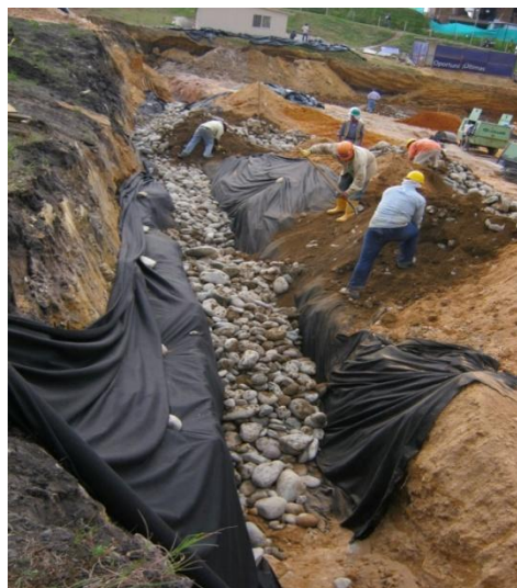
Figura 12. Construcción filtro francés
