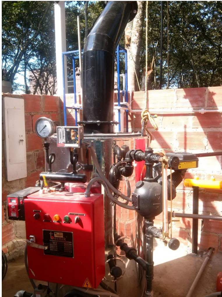
Figura 14. Caldera Tecnik® de 6 BHP
