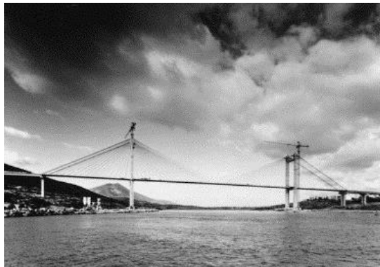
Figura 12. Puente Evripos, Grecia.
