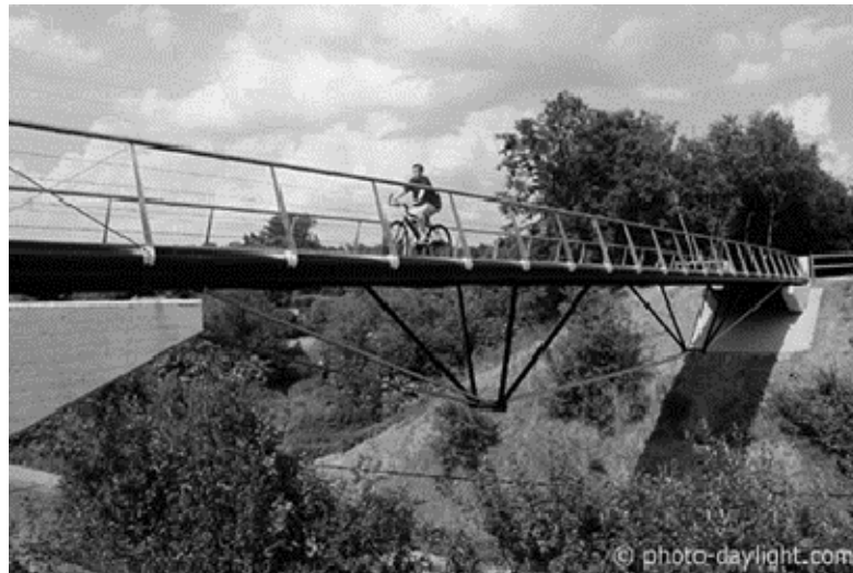
Figura 6. Puente peatonal de Jumet.
