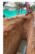
Imagen No. 1. Zanja de excavación para tubería de 36" 8" y 6"
