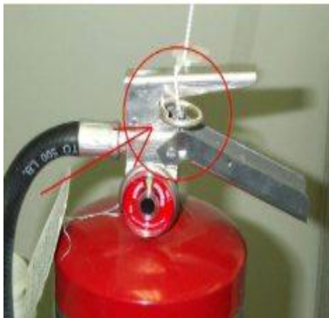
Figura 1.3. Pasador de seguridad del extintor
