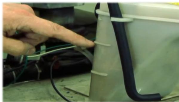
Figura 4. Deposito de liquido refrigerante
