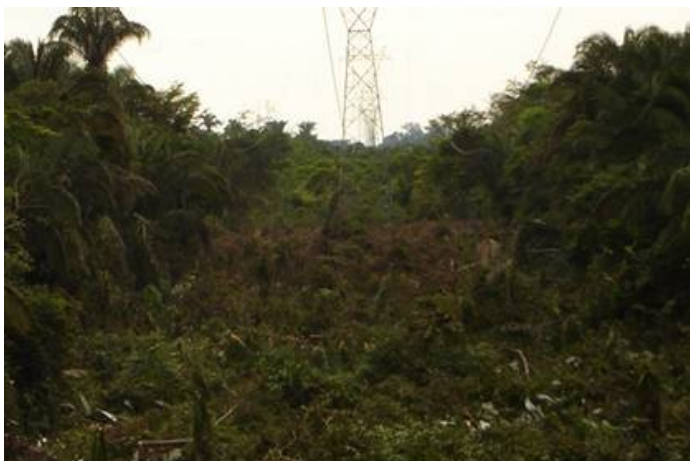
Figura 25. Mantenimiento de servidumbres
