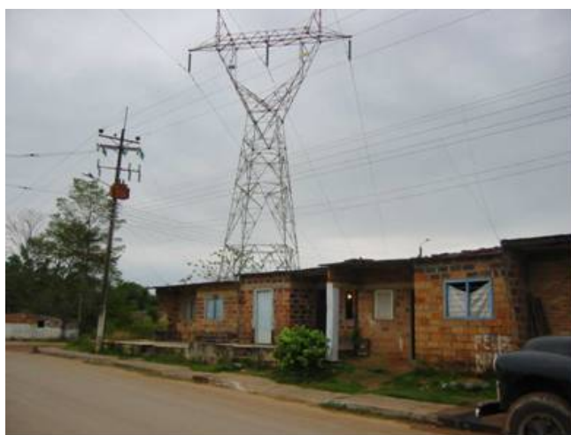
Figura 24. Invasión de la zona de servidumbre.
