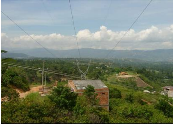
Figura 1. Construcciones dentro de la zona de servidumbre
