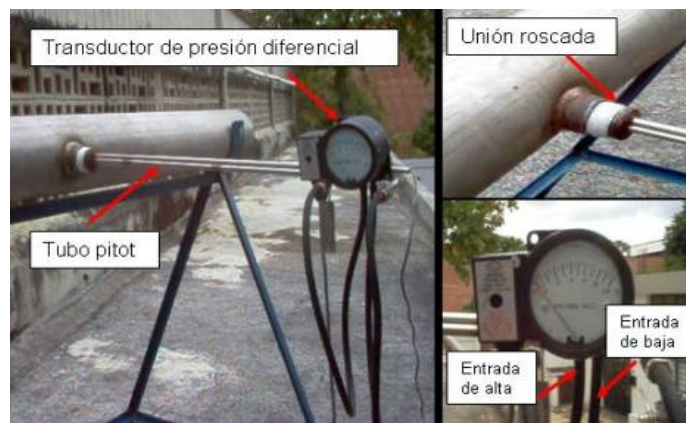
Figura 21. Montaje del tubo Pitot y transductor de presión diferencial.
