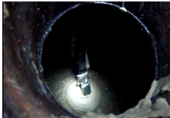
Figura 36 . Proceso de agitación del recubrimiento refractario
