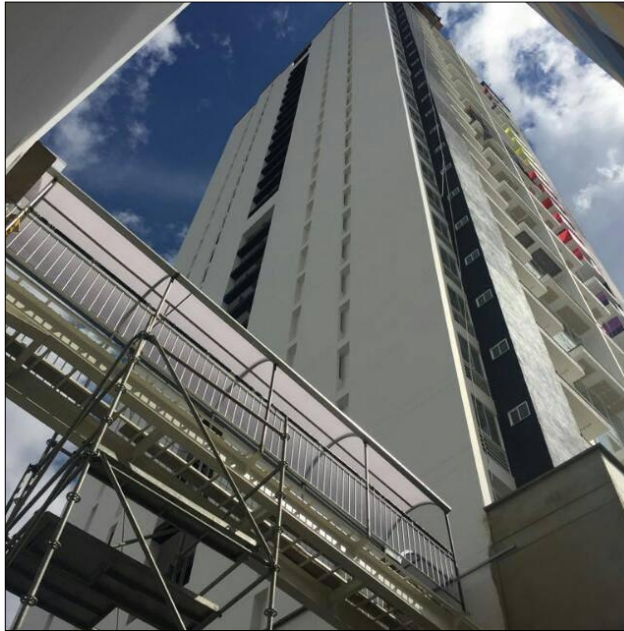
Fig. 17 Etapa de Construcción de la pasarela peatonal
