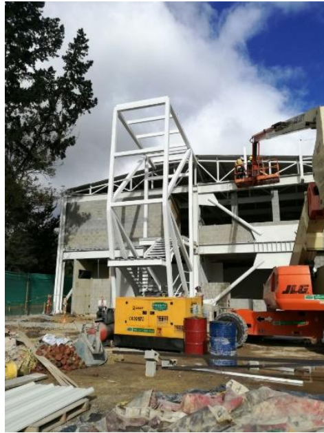
Fig. 11 Etapa final de construcción de la estructura
