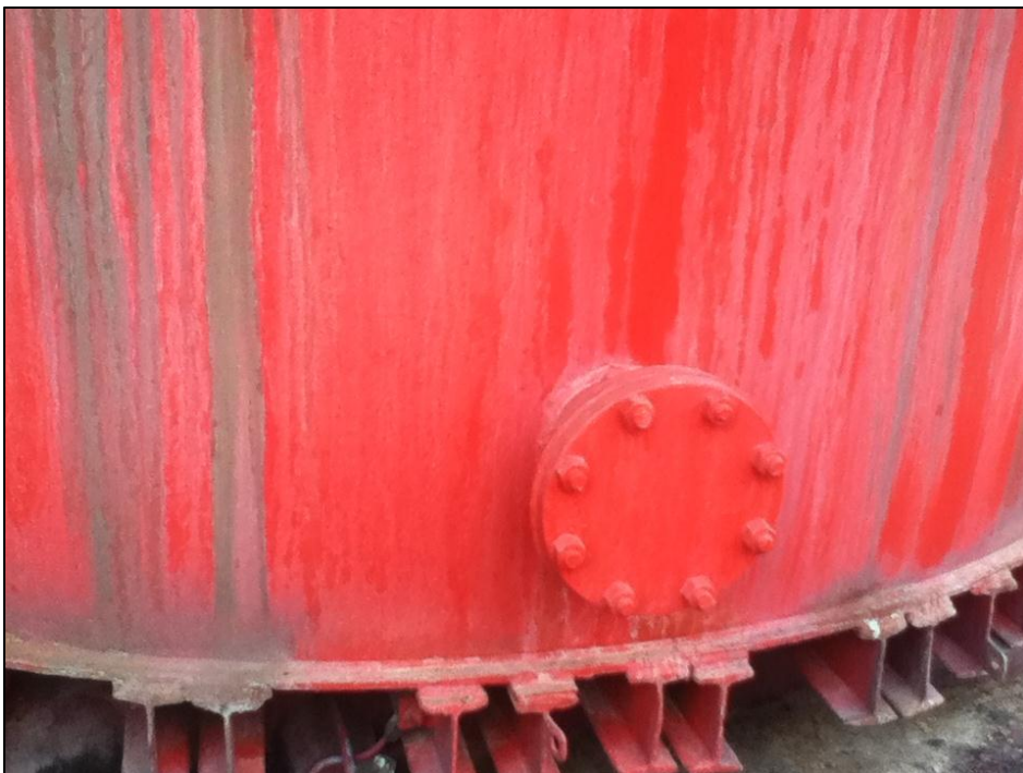
Figura 34. Ciegos del tanque
