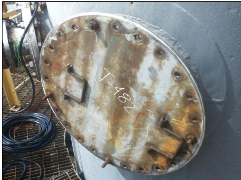
Figura 33. Entrada superior. Manhole
