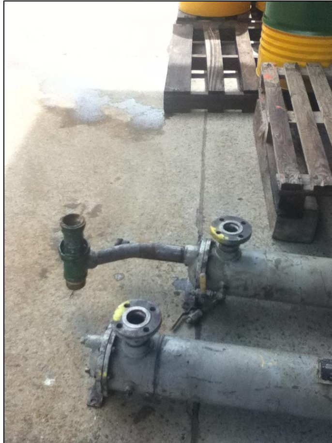
Figura 30. Intercambiadores desmontados.
