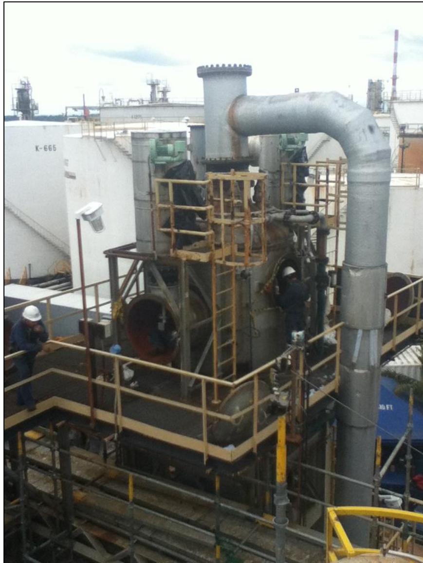
Figura 31. Precipitador electrostático
