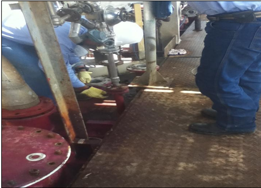
Figura 22. Instalación de ciegos
