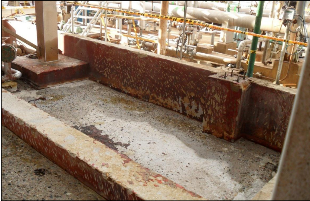
Figura 20. Dique, efectos del ácido
