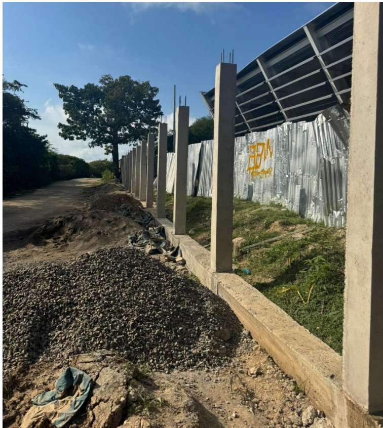
Columnas de concreto del cerramiento perimetral
