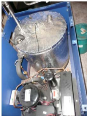
Figura A3. Sistema de enfriamiento de la planta piloto de cristalización
