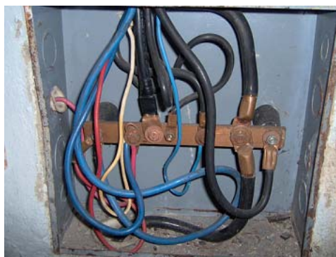
Figura 2.8 Caja de conexiones de PT
