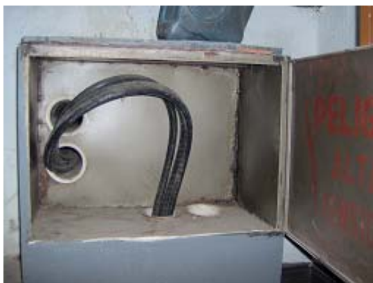
Figura 2.1 Alimentador en MT
