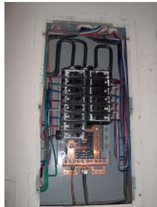
Figura 2.56 Tablero de uso final TI2
