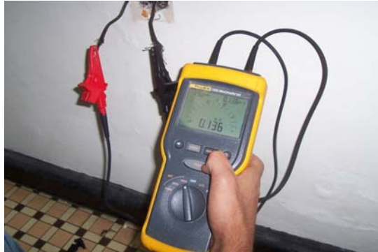
Figura 3.1 Medida de resistencia de aislamiento entre fase y neutro
