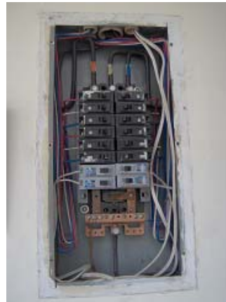
Figura 2.60 Tablero de uso final TA3
