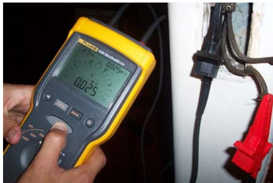
Figura 3.2 Medida de resistencia de aislamiento entre fase y tierra
