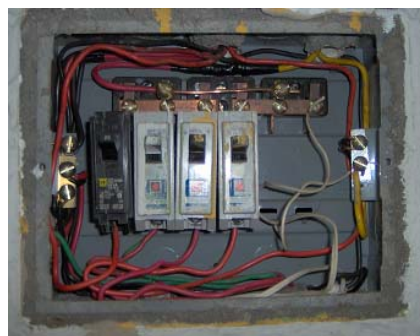
Figura 2.24 Tablero de uso final TB
