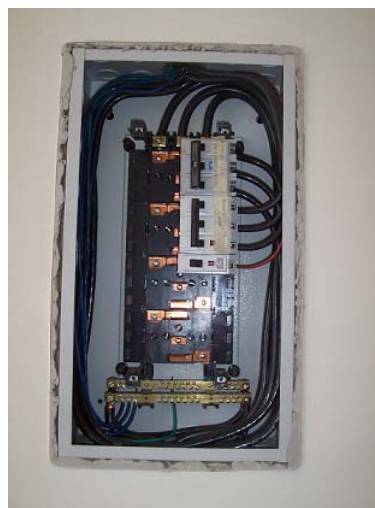
Figura 2.18 Tablero General de baja tensión TGBT4
