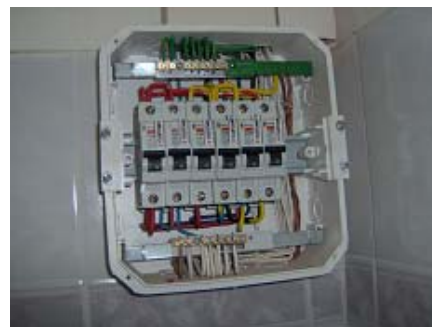
Figura 2.69 Tablero de uso final TJ3
