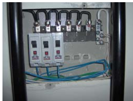
Figura 2.41 Tablero de uso final TK1
