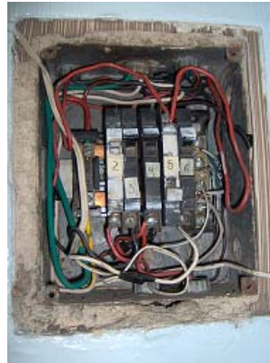
Figura 2.26 Tablero de uso final TD
