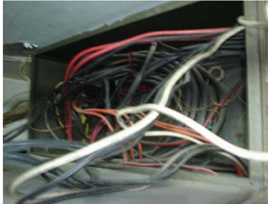
Figura 2.6 Acometidas en TGA
