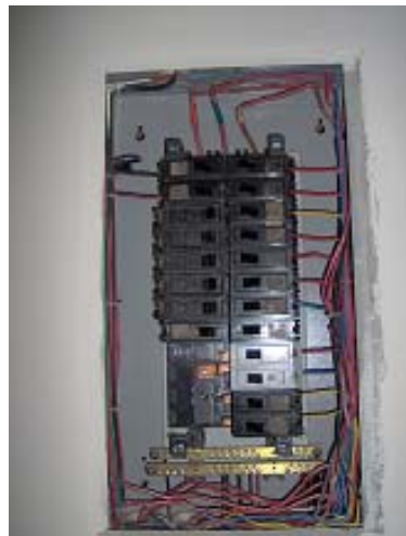
Figura 2.38 Tablero de uso final TH1
