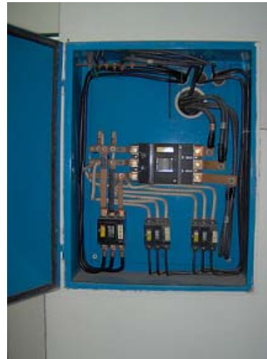
Figura 2.19 Tablero General de baja tensión TGBT5
