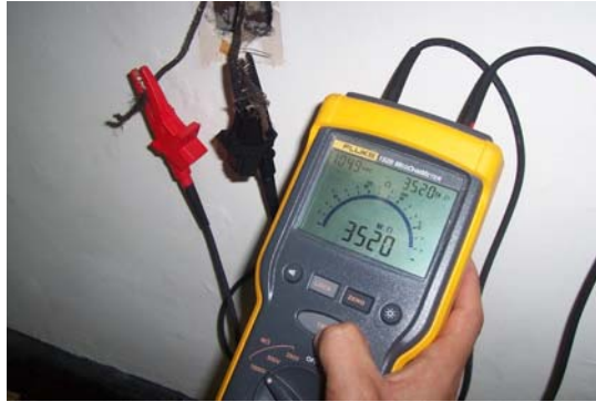
Figura 3.3 Medida de resistencia de aislamiento entre recubrimientos de fase y neutro
