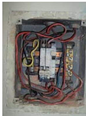
Figura 2.27 Tablero de uso final TE y contador
