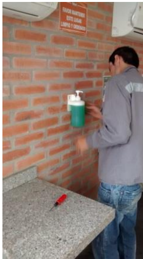
Figura 21. Instalación dispensadores de jabón líquido desinfectante.
