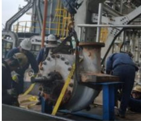
Figura 45. Proceso de mantenimiento de una bomba de diesel producto.
