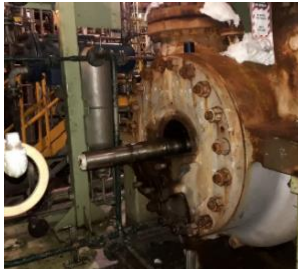
Figura 46. Cambio de rodamientos de una bomba de diesel producto.
