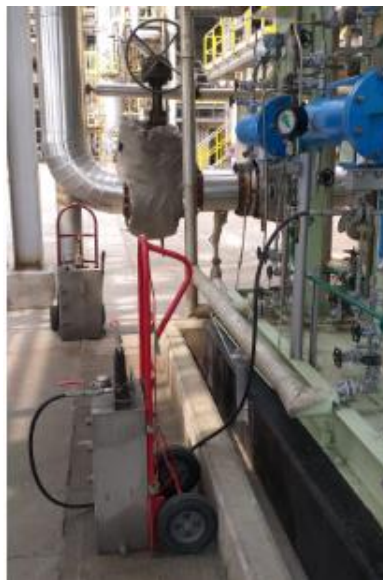
Figura 79. Ajuste de presión de líquido barrera.
