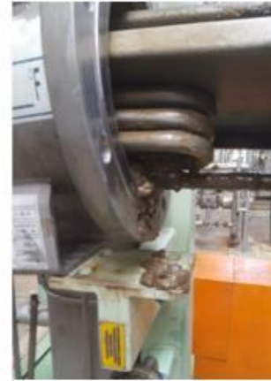
Figura 50. Enfriador de sistemas de sello de una bomba de diesel producto.
