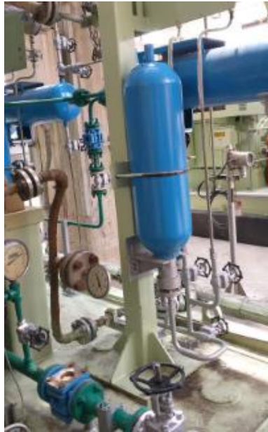
Figura 80. Ajuste de presión de N2 en acumulador de sistema de sello.
