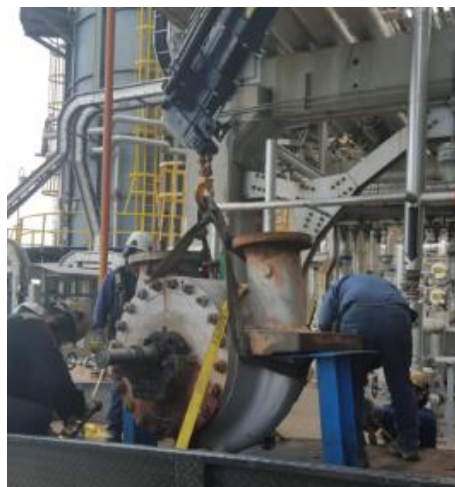
Figura 82. Reparación de sello mecánico.
