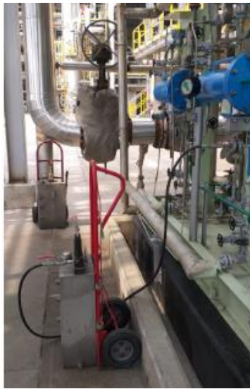
Figura 81. Cambio de líquido barrera.
