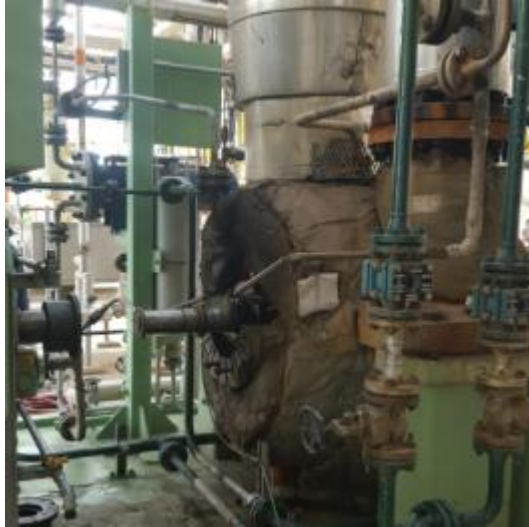
Figura 93. Cambio de rodamientos bomba centrífuga.
