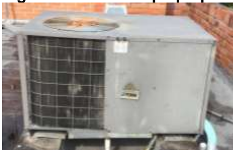
Figura 20. Unidad tipo paquete de expansión directa PAQ-06
