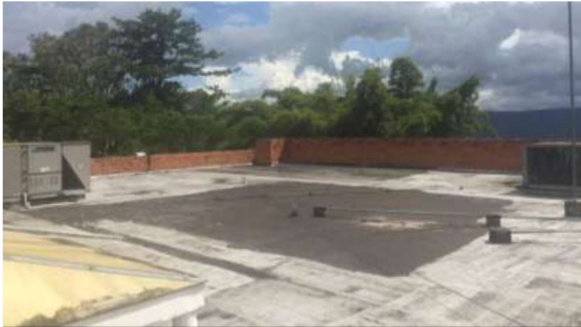
Figura 5. Registro fotográfico de la cubierta del edificio ABP (II)
