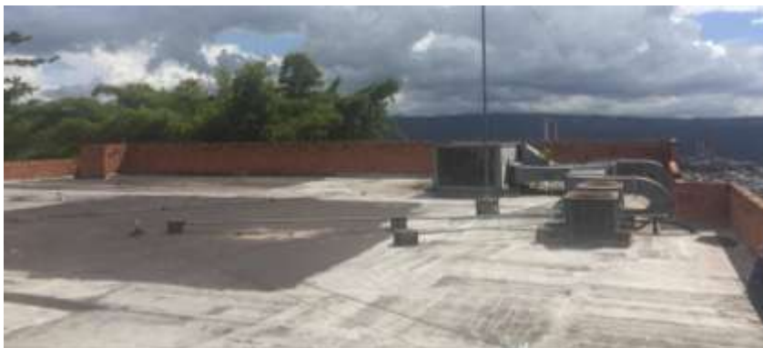
Figura 4. Registro fotográfica de la cubierta del edificio ABP (I)
