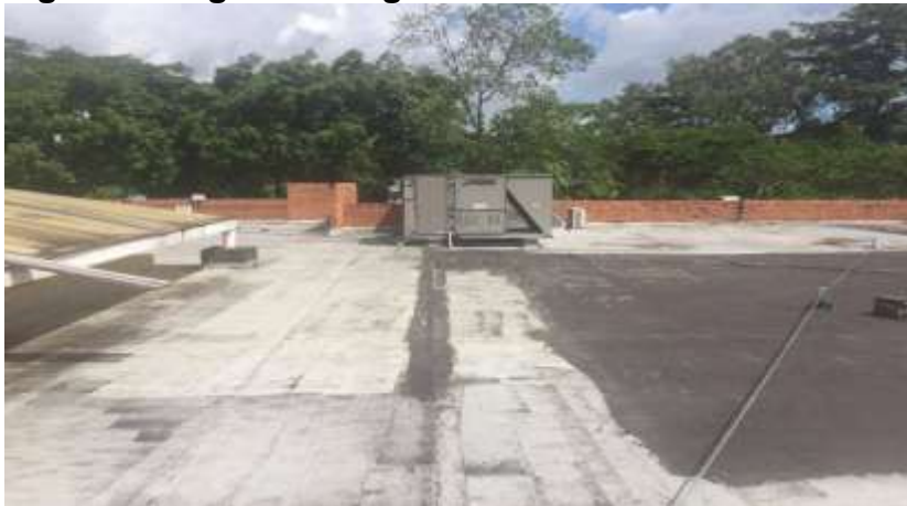
Figura 6. Registro fotográfico de la cubierta del edificio ABP (III)
