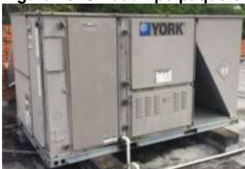
Figura 19. Unidad tipo paquete de expansión directa PAQ-05
