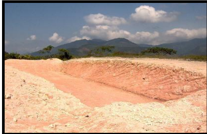
Figura 9. Adecuaciones para la tercera etapa de operación del relleno sanitario
