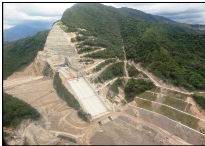
Figura 1. Proyecto Hidroeléctrico Sogamoso
