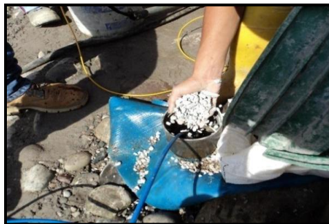
Figura 6. Elaboración del sello de Bentonita
