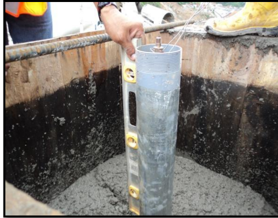
Figura 4. Nivelación del cilindro metálico del mojón de control
