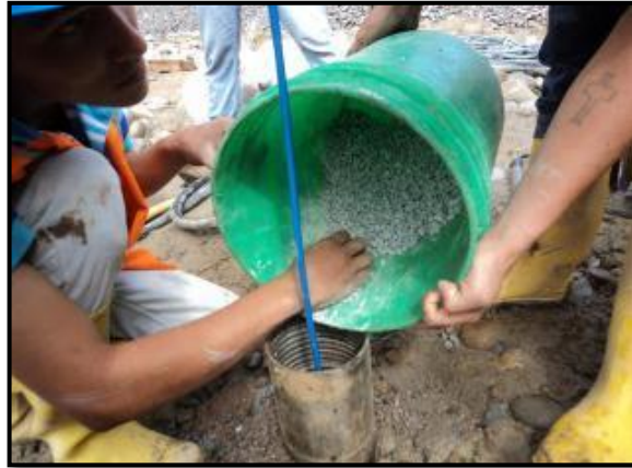
Figura 7. Descenso del piezómetro
