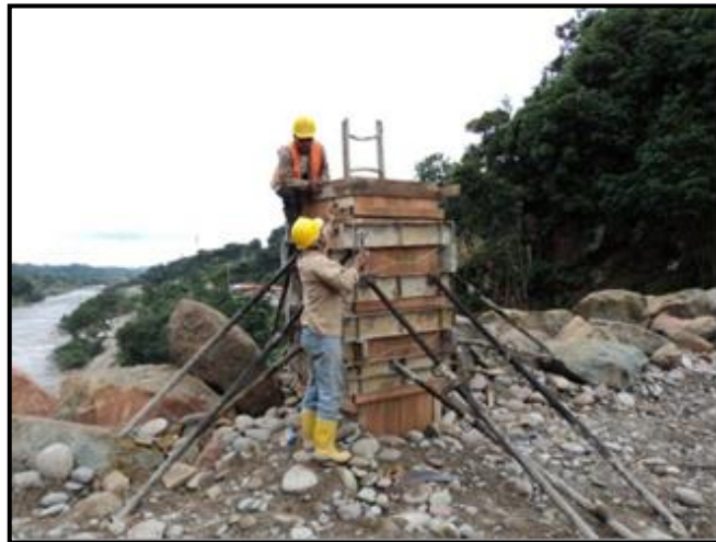
Figura 3. Formaleta para el mojón de control
