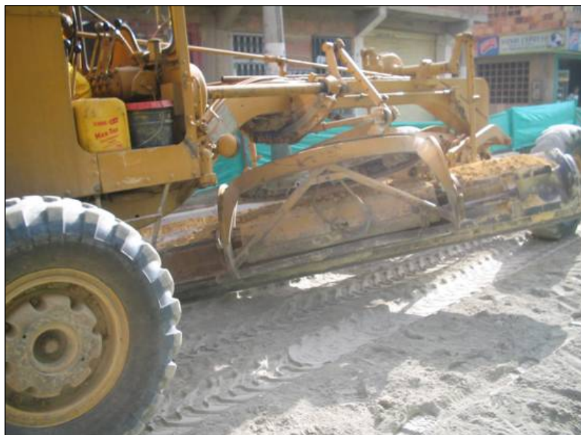
Figura 42. Mezcla de suelo-cemento utilizando motoniveladora
