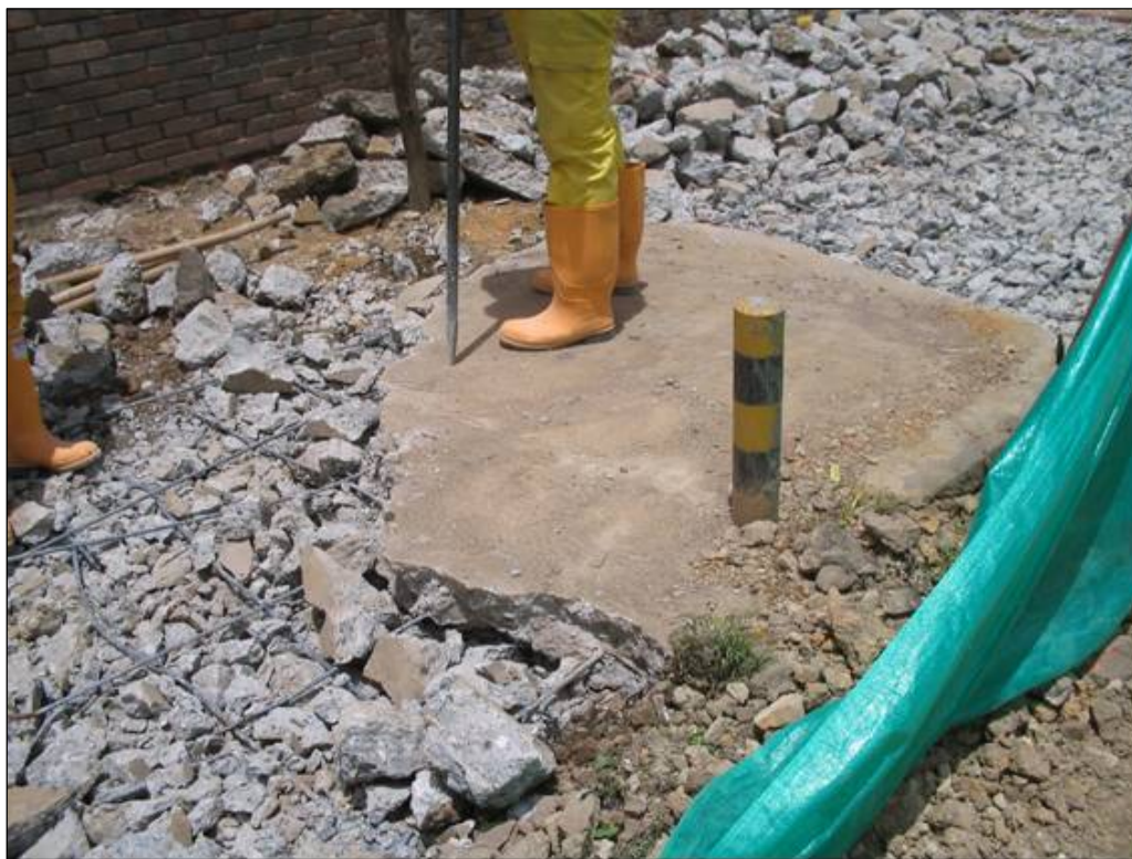
Figura 53. Demolición manual de andenes
