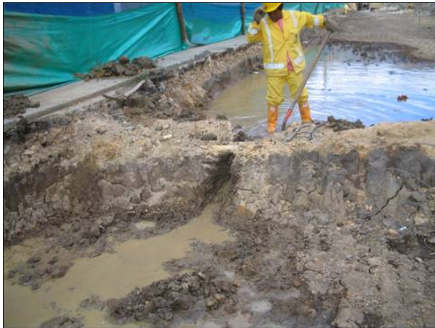
Figura 31. Adecuación de drenaje por medio de Zanjas excavadas manualmente
