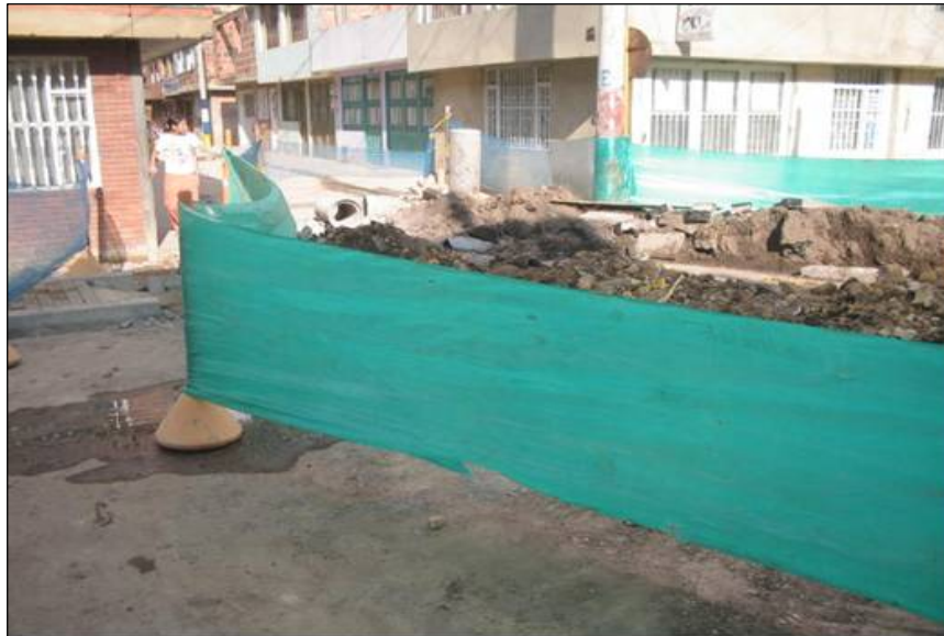
Figura 15. Cerramiento en Polisombra para delimitar área de intervención
