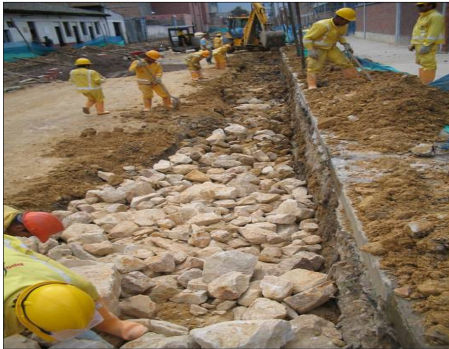
Figura 30. Relleno posterior a una excavación de Fallo
