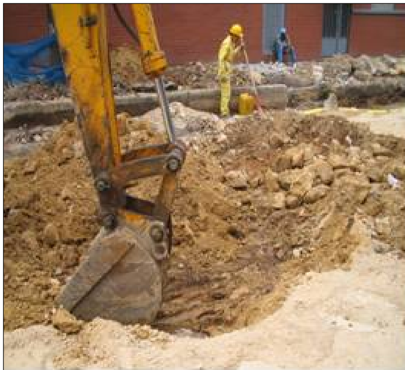
Figura 8 Inicio de Excavación Mecánica
