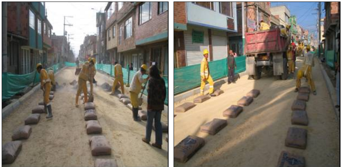
Figura 38. Distribución del cemento para garantizar dosificación de diseño
