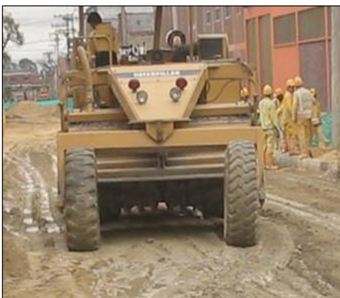
Figura 36. Recicladora o Fresadora de Pavimento y Carro tanque para suministro de agua
