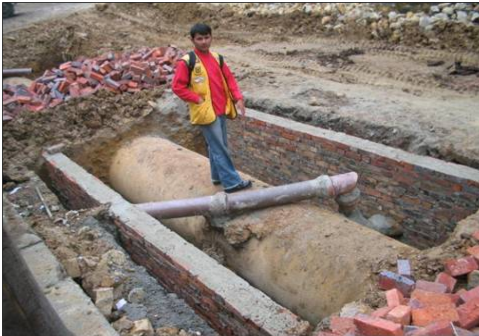
Figura 24. Construcción carcamo de protección tubería red matriz acueducto \varphi = 36''
