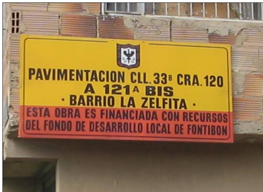
Figura 16. Identificación de la Obra en ejecución
