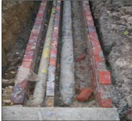
Figura 23. Diversos carcamos de protección de redes ubicadas sobre la calzada en Intervención
