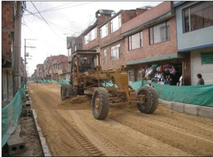
Figura 32. Extensión de material de Sub base Granular con Moto niveladora
