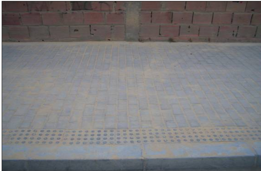
Figura 61. Escobillado final para sello de juntas en área adoquinada
