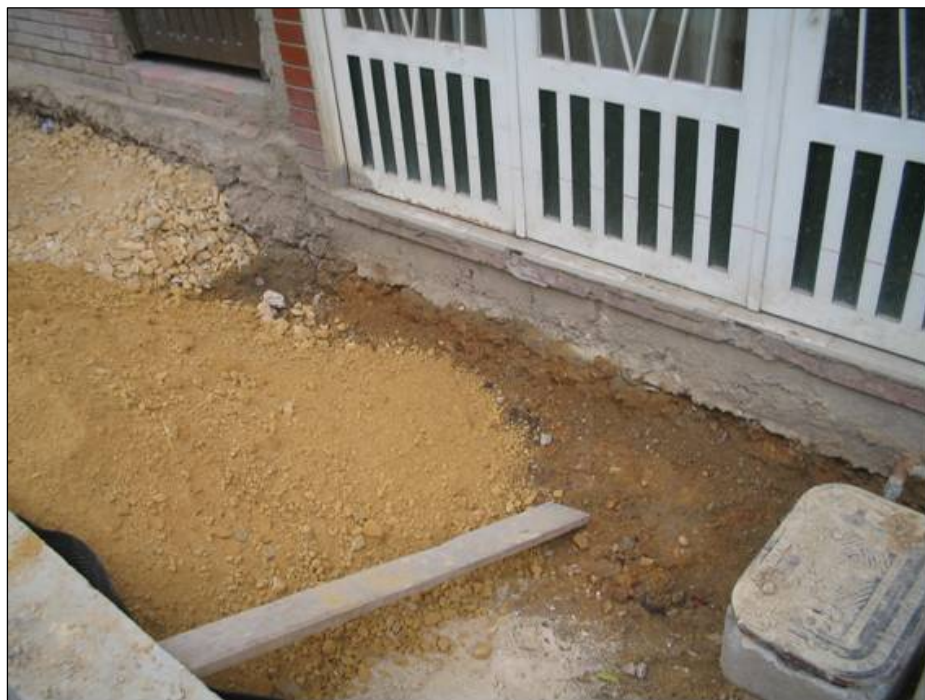
Figura 58. Inicio de rellenos en andenes
