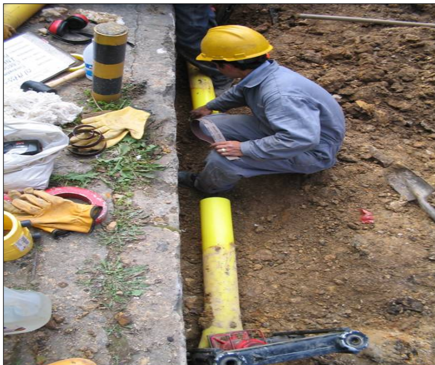
Figura 11 Arreglo daño tubería de Gas Natural \phi=4''
