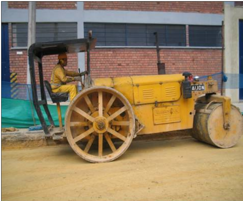
Figura 29. Compactación de sello en B-200 con cilindro Estático Galion Warrior
