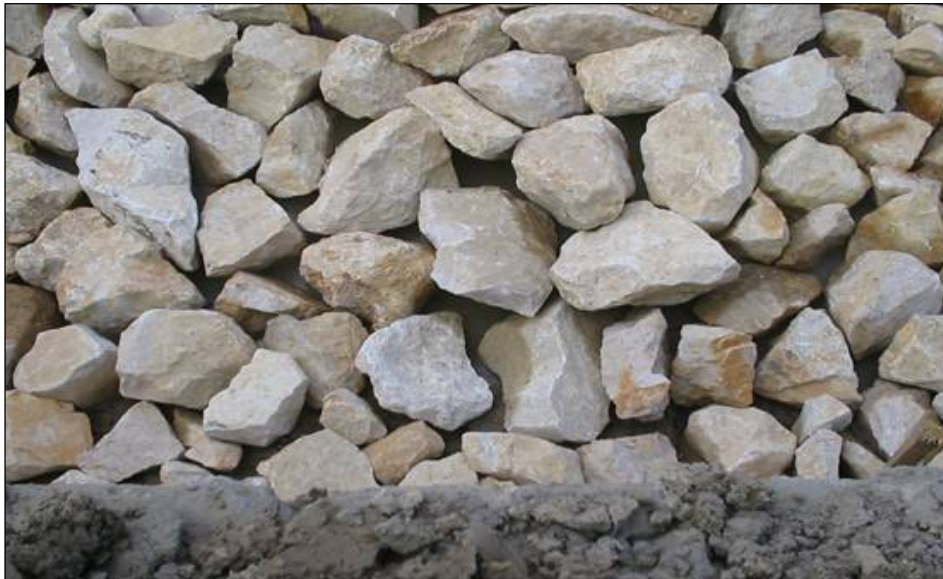
Figura 27. Vista superior pedraplen
