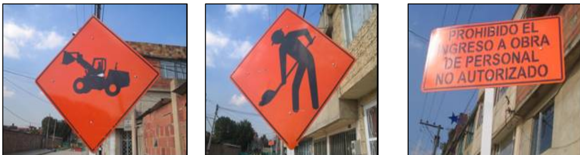
Figura 17. Algunas de las señalizaciones más comunes en los frentes de obra
