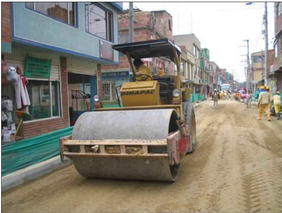
Figura 46. Compactación de la Base Estabilizada
