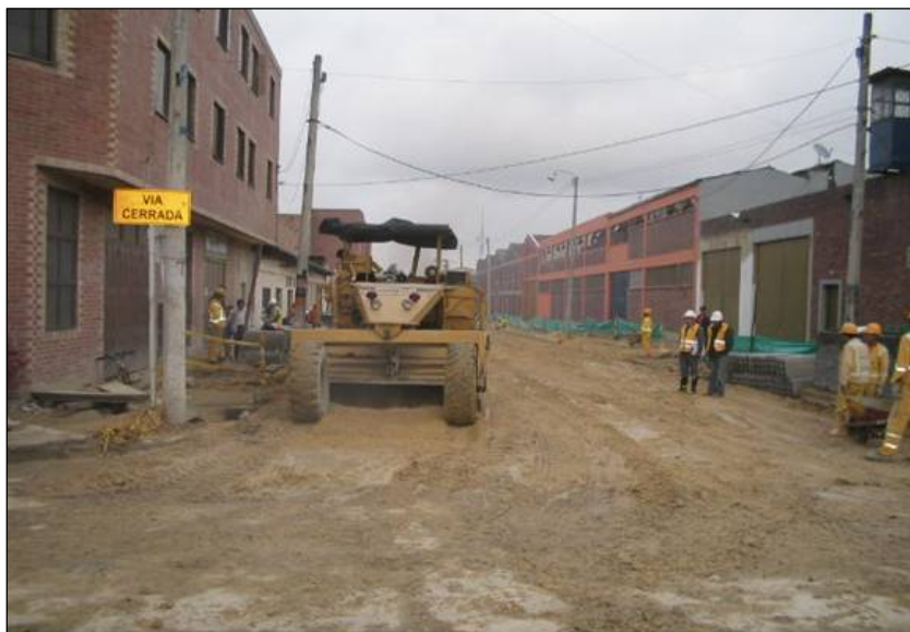
Figura 43. Mezcla de suelo-cemento utilizando Recicladora de Pavimento
