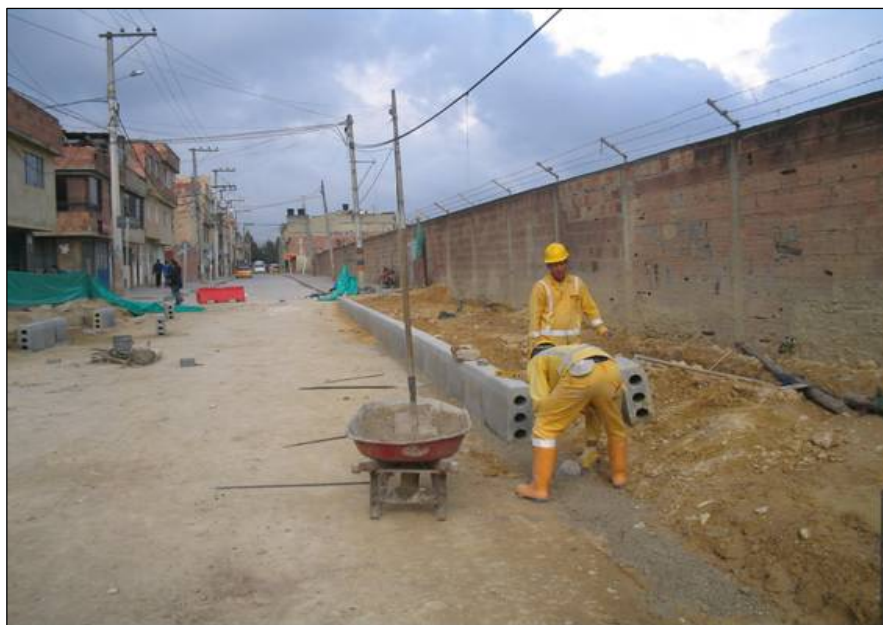
Figura 57. Instalación Sardinel A-10
