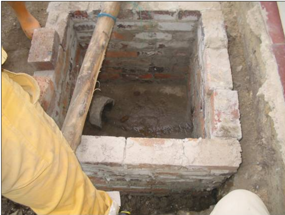
Figura 55. Adecuación de caja de inspección aguas negras
