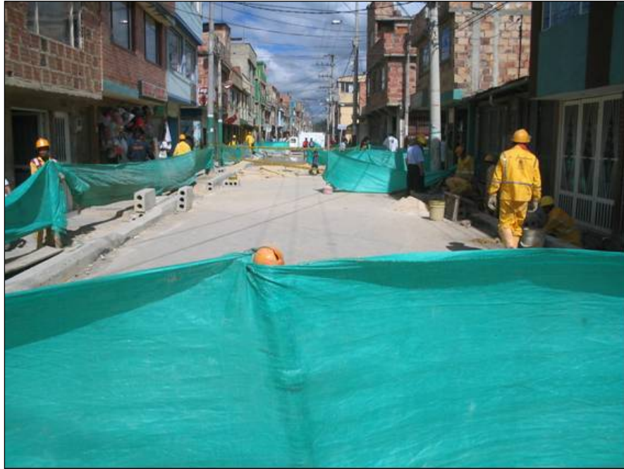
Figura 52. Señalización con polisombra
