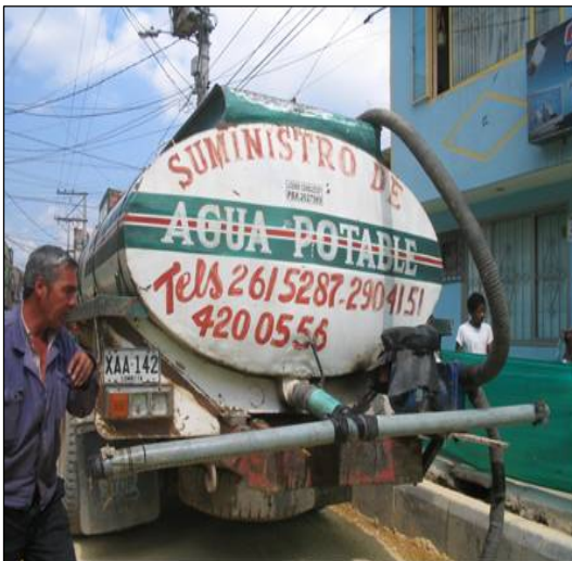
Figura 34. Carro tanque con flauta y densímetro nuclear para adecuación de humedades
