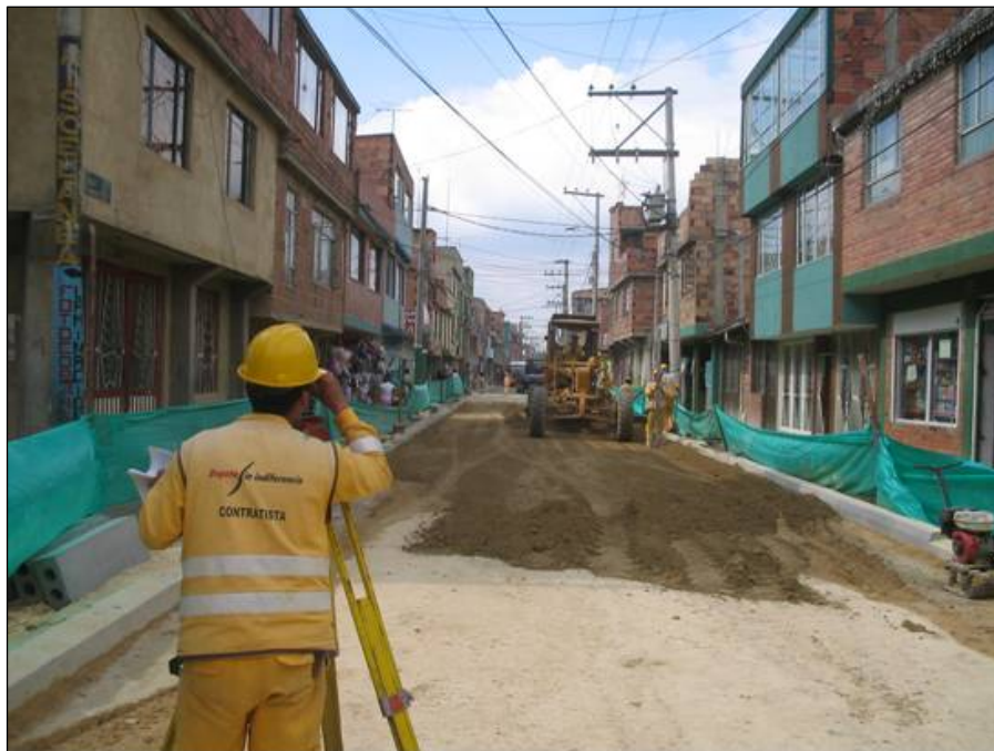
Figura 33. Nivelación Topográfica a cargo de la comisión del contratista
