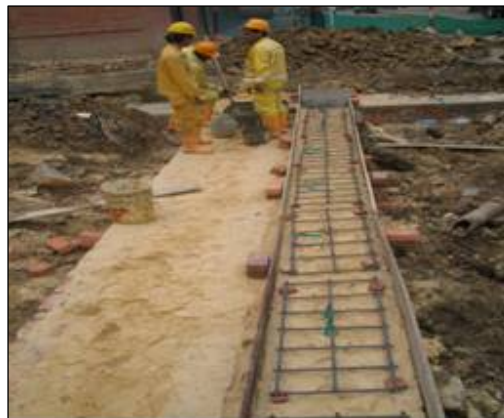
Carcamo de Protección Acueducto Losas superiores reforzadas carcamo
