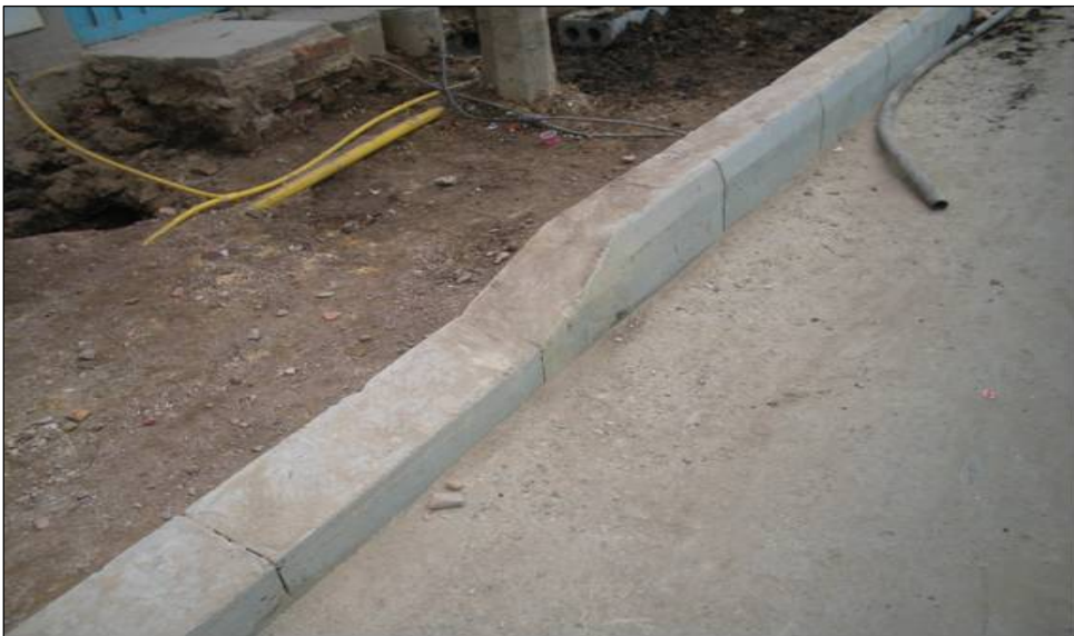
Figura 54. Excavación realizada para conformación de estructura de andén
