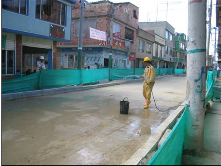
Figura 47. Humedecimiento de la superficie compactada para mantener la humedad antes del riego de curado
