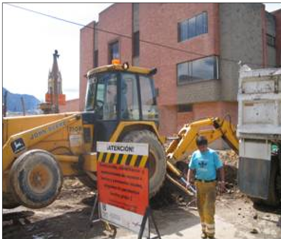
Figura 7. Retroexcavadora Jonh Deer 710 Haciendo cargue de Volquetas
