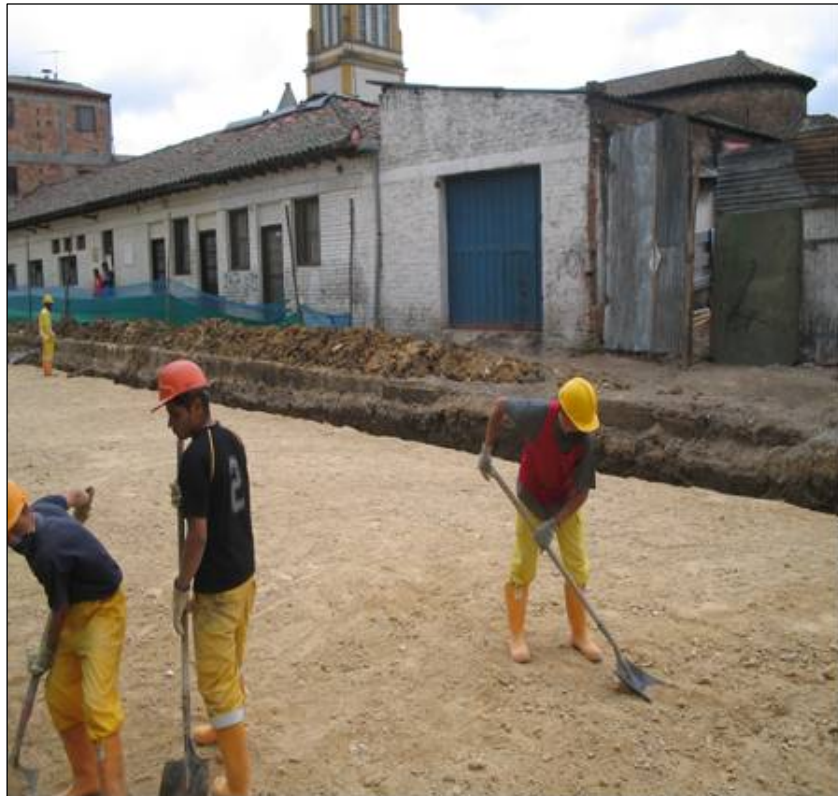
Figura 28. Extensión manual de sello en recebo B-200 para protección del pedraplen
