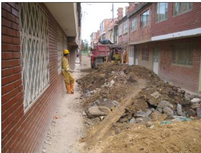
Figura 18. Acopio de Material de Excavación para su posterior evacuación
