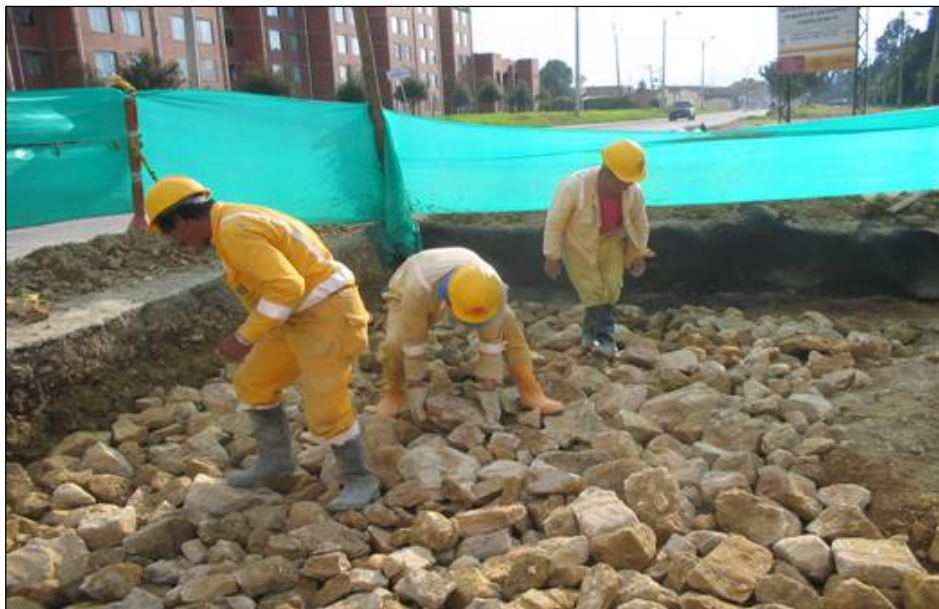
Figura 22. Acomodación manual del pedraplen sobre subrasante a estabilizar
