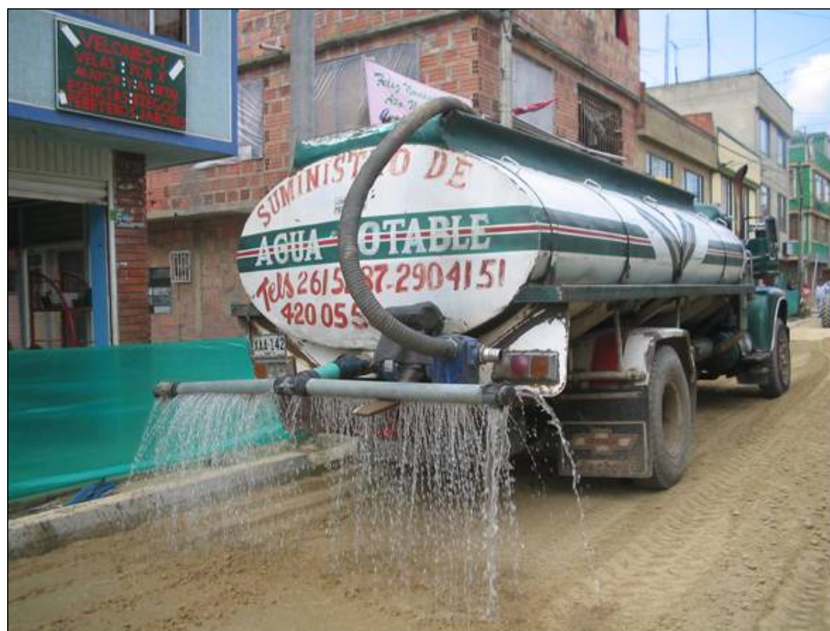
Figura 44. Humedecimiento de la mezcla para alcanzar la humedad optima
