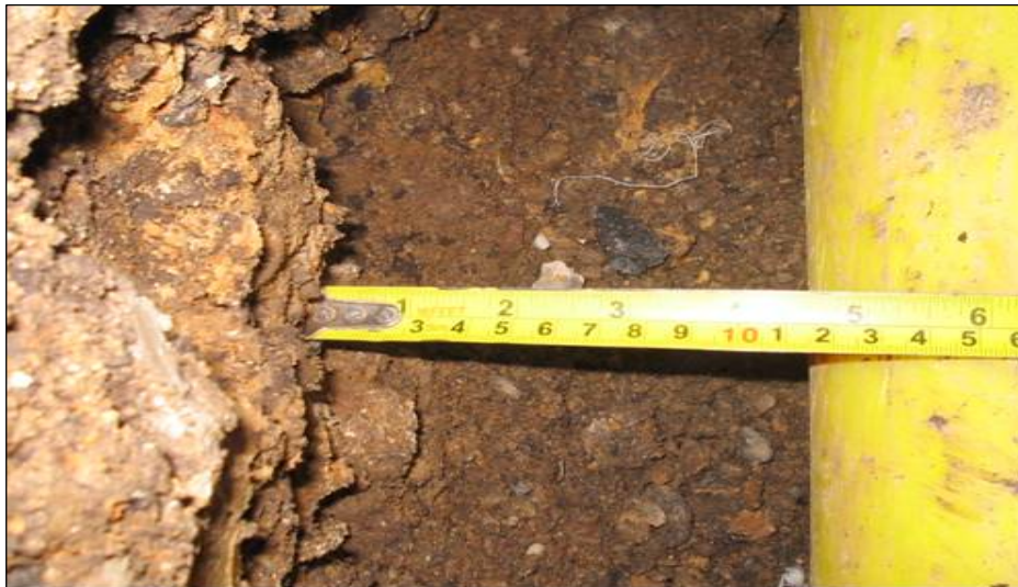
Figura 13. Ubicación Real tubería de Gas Natural \phi=4''
