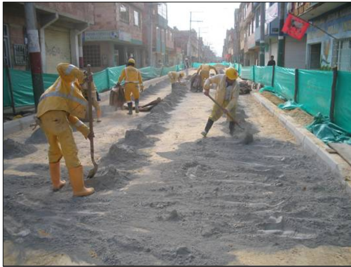
Figura 39. Distribución manual del cemento a todo lo ancho de la calzada a estabilizar
