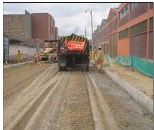
Figura 36. Recicladora o Fresadora de Pavimento y Carro tanque para suministro de agua
