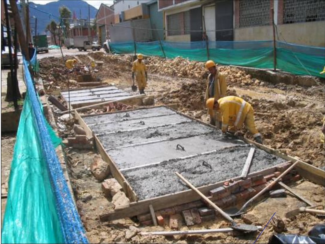
Figura 25. Allanado a mano de las losas superiores del carcamo de protección tubería red matriz acueducto \varphi = 36''
