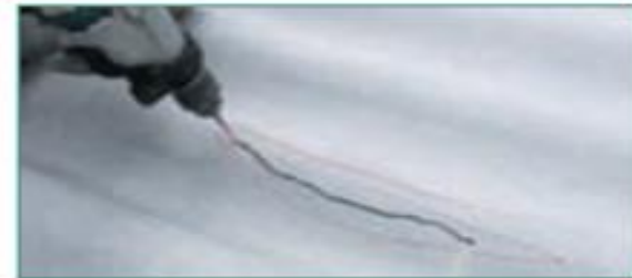
Tratamiento de la fisura
