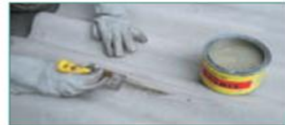
Relleno de la fisura con pegante epóxico
