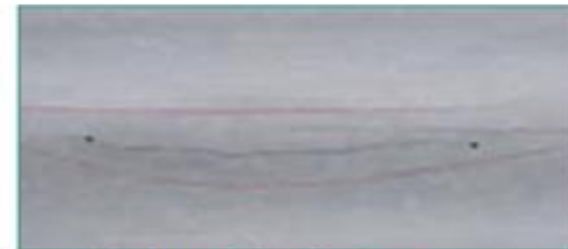
Perforación de los extremos de la fisura
