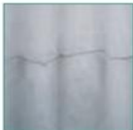
Fisura Transversal
