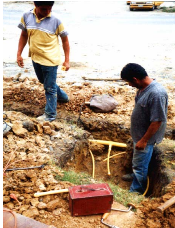
FOTO 12. Ejecución de acometidas domiciliarias tubería de media pulgada (1/2"), derivación a la vivienda desde el anillo, tubería de tres cuartos (3/4")
