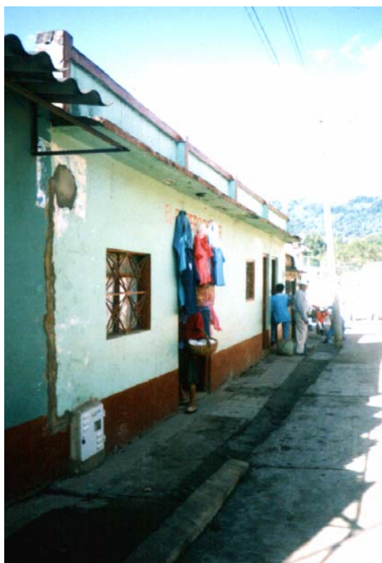
FOTO 9 y 10. Arriba se aprecia la vía nacional Bucaramanga – Bogotá que cruza el municipio de Barbosa. Abajo se observa la tipología de vivienda predominante en los municipios objeto de estudio (un nivel), a excepción del municipio de Barbosa donde se presentan viviendas de dos y hasta cinco niveles.
