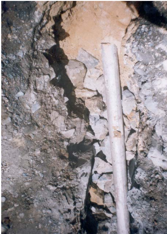
FOTO 11. Se aprecia en el recorrido del City Gate a la cabecera municipal la aplicación de la NTC 3728, cuando la tubería no alcance la profundidad estipulada por la norma, se debe encamisar en tubería de acero dos (2) pulgadas mayor que el diámetro de la tubería que encamisa, con el objeto de proteger la tubería de agentes externos..
