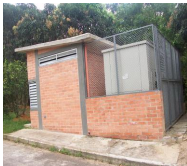
Figura 11 Caseta- Subestación Eléctrica Planta De Emergencia [17]
