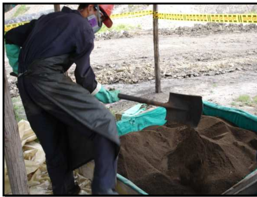
Figura 17. Aireación de los tratamientos de forma manual.
