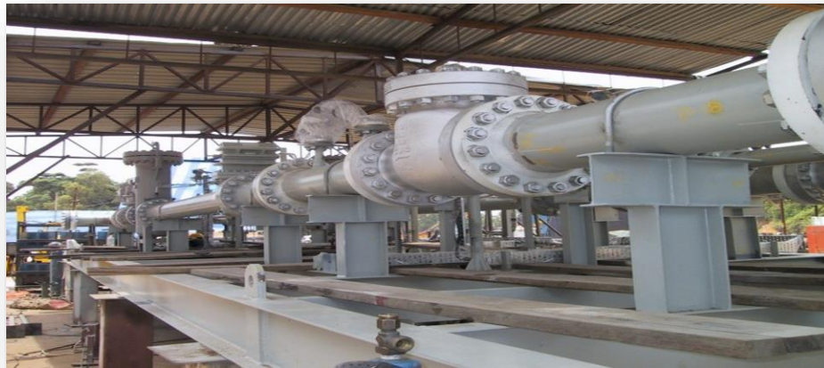
Figura 50. Sistema de medición 1+0 con portaplaca (portaplatina)
