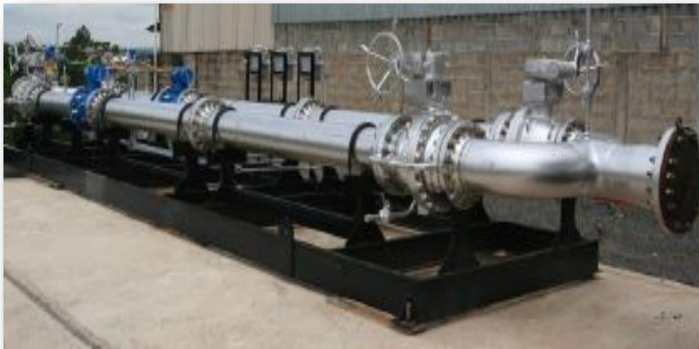
Figura 51. Unidad de medición de gas en configuración 1+1
