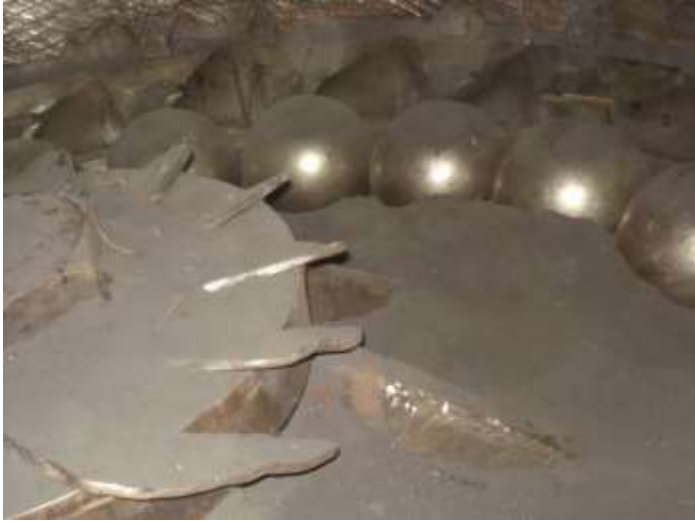
Figura 21. Acumulación de ceniza en cámara de molienda.
