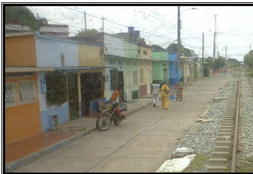
Figura 15. Viviendas ubicadas a menos de 6 metros de la línea férrea. Fuente: POT Barrancabermeja, encuesta de Campo realizada en diciembre de 2005.
