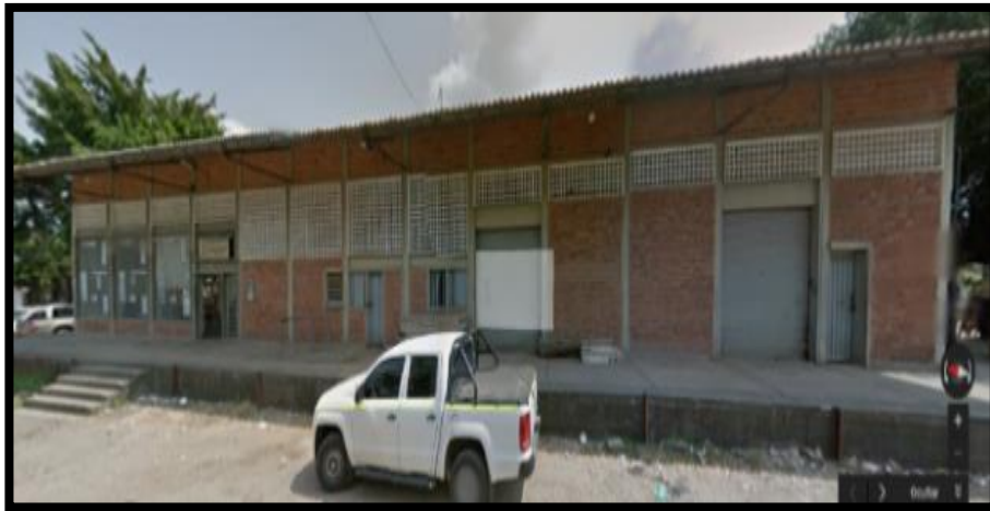
Figura 21. Estación del Ferrocarril actual de la ciudad de Barrancabermeja (Santander).
