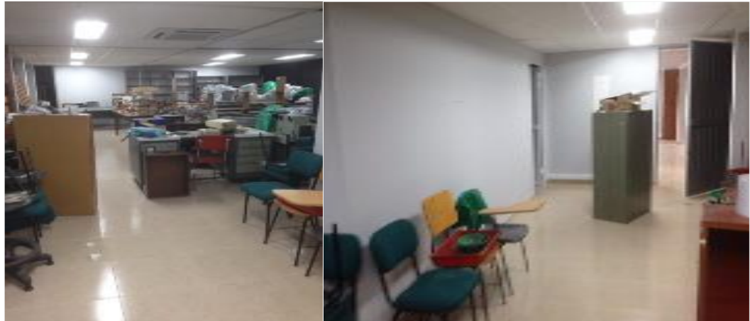
Figura 7. Foto de las adecuaciones ya realizadas del salón óptica de posgrados de física.
