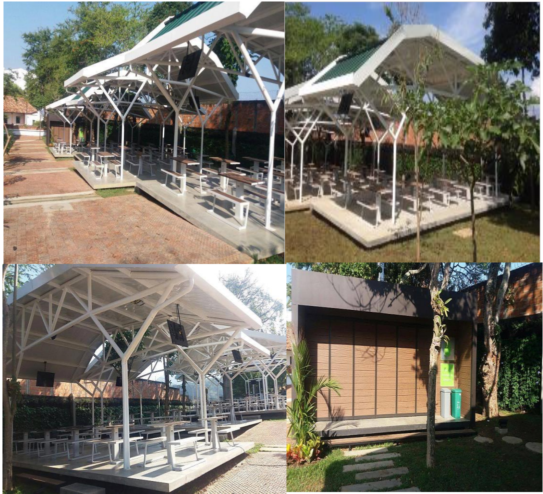
Figura 14. Módulos exteriores de bienestar universitarios terminados.
