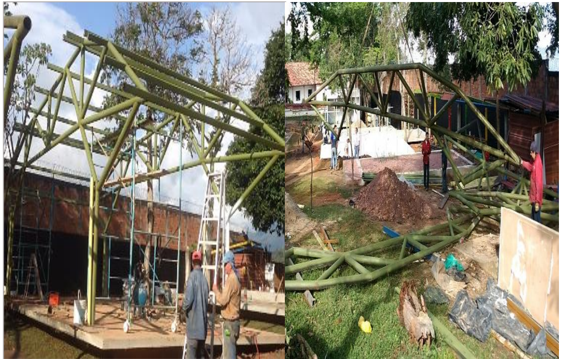
Figura 13. Estructura metálica de los módulos exteriores de bienestar universitario.
