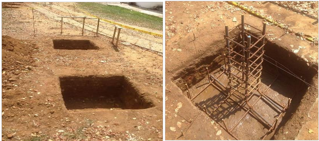
Figura 10. Cimentación de zapatas los módulos exteriores de bienestar universitario
