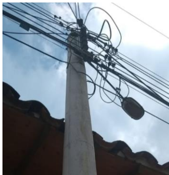
Imagen 4. Luminaria alumbrando el techo de una residencia.
