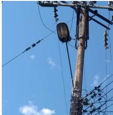
Imagen 9. Luminaria sin reflector exponiendo los componentes eléctricos.
