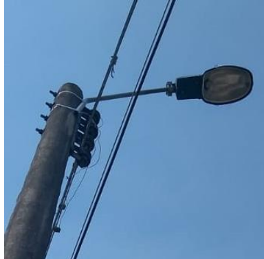
Imagen 9. Luminaria sin reflector exponiendo los componentes eléctricos.
