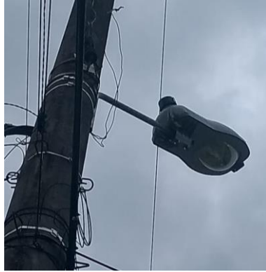
Imagen 6. Luminaria de ornamentación en muy mal estado en el parque de Riachelo.
