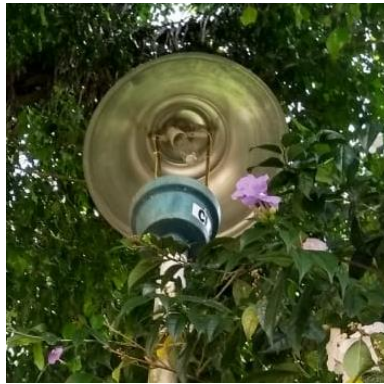
Imagen 6. Luminaria de ornamentación en muy mal estado en el parque de Riachelo.
