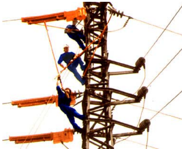
Figura 16. Trabajos mediante la técnica a distancia [9].
