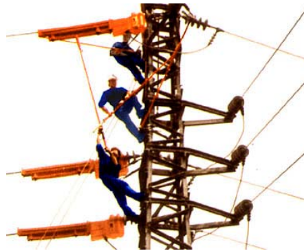
Figura 4. Trabajos mediante la técnica a distancia [9].
