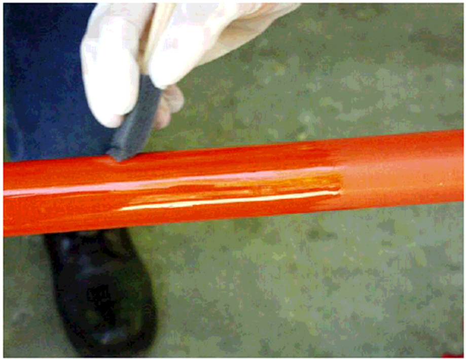
Figura 22. Proceso de aplicación de epóxico [9].
