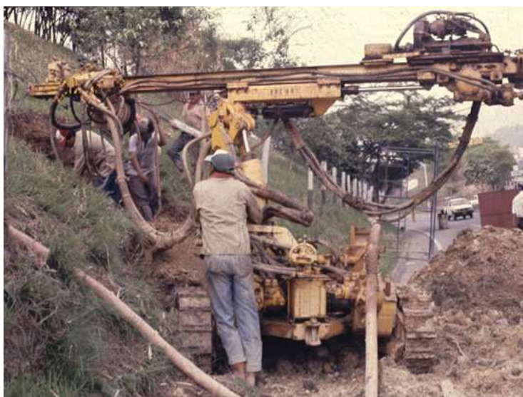
Fig. 19. Construcción de un dren 5
