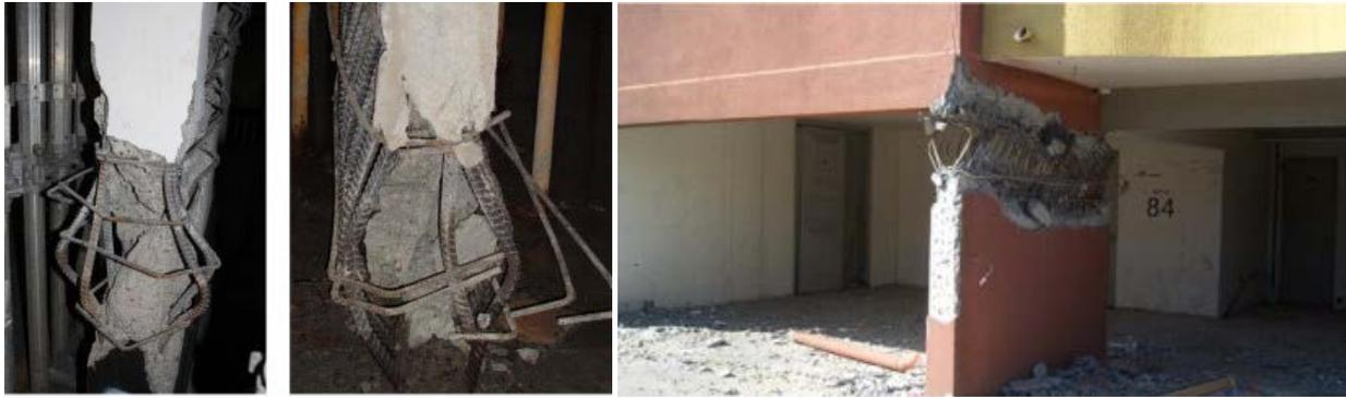
*Figura 1* Falla típica por flexo-compresión en muros de concreto reforzado durante el terremoto de Chile de 2010, incluyen aplastamiento del concreto, pandeo del refuerzo vertical y apertura del refuerzo horizontal. Alarcon, C (2014). Effect of axial loads in the seismic behavior of reinforced concrete walls with unconfined wall boundaries. [Fig. 1]. Recuperado de <http://www.sciencedirect.com/science/article/pii/S0141029614002697?via%3Dihub>.
