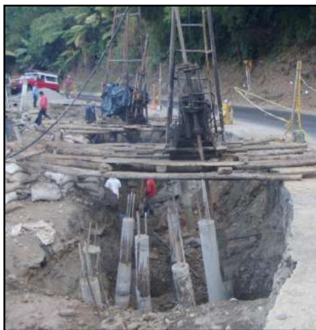
Figura 1. Micropilotes inclinados; Geotecnología S.A.S
