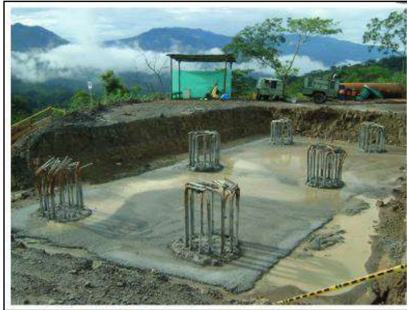
Figura 4. Pilotes pila 1 Puente Mata de Cacao - octubre de 2012; Geotecnología S.A.S
